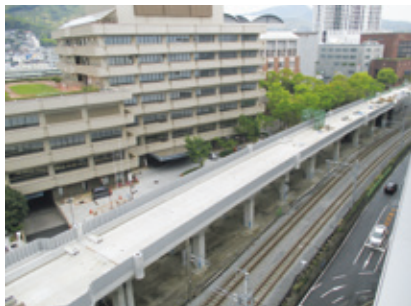
JR長崎本線におけるFRP製壁高欄設置状況 (九州旅客鉄道)
