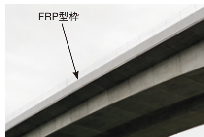
高倉川橋（PC上部工の埋設型枠への適用） (NEXCO東日本 令和2年度施工中)
