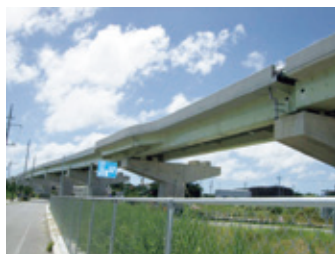
豊見城高架橋 (沖縄総合事務局 平成20年度竣工)
