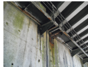
鋼製検査路の腐食による損傷の例
