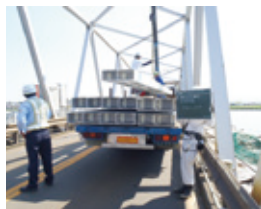
検査路の荷卸し (ユニック車)
