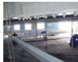
桁下足場上での移動
