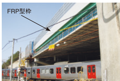
九州道 向佐野橋 (NEXCO西日本 平成22年度竣工)
