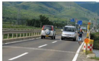
歩道の必要幅員が確保されていない橋梁例2
