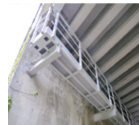
熊坂橋下部工検査路 (FRPブラケット仕様) (NEXCO中日本 平成23年度竣工)
