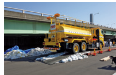
F-Deckにより通行可能
