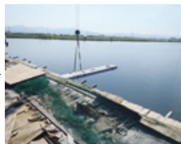
桁下の足場への取込み
