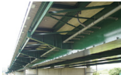
新名神高速道路 木津川橋他3橋 (NEXCO西日本 平成27年度竣工)
