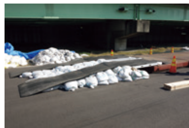
軽量土嚢によるスロープ構築
