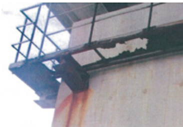
鋼製検査路の腐食による損傷の例
