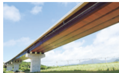
下田原大橋 (沖縄県 令和2年度竣工)
