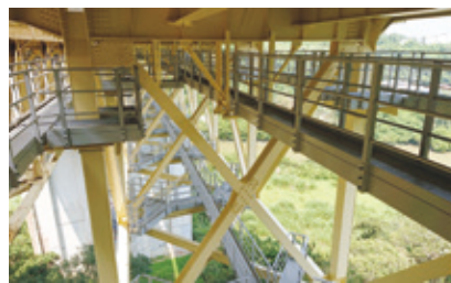
福地川橋上部工検査路 (トラス橋への設置) (NEXCO西日本 平成30年度竣工)
