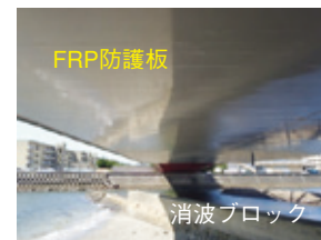
FRP防護板 消波ブロック 防護板設置完了
