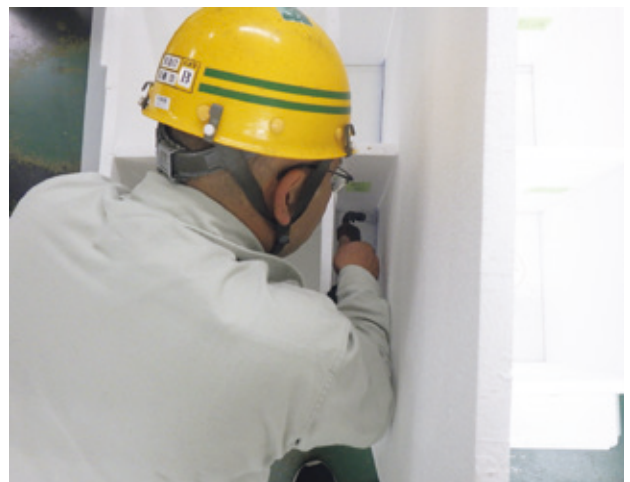
図-6 モックアップによる溶接作業性の確認
