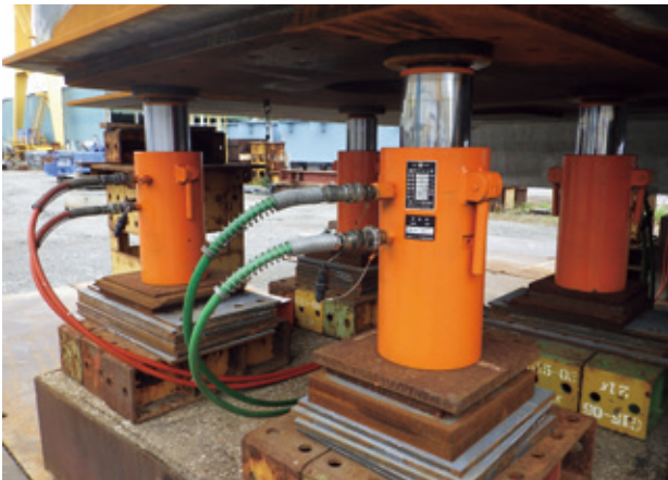
図-8 支点位置でのジャッキアップ状況
