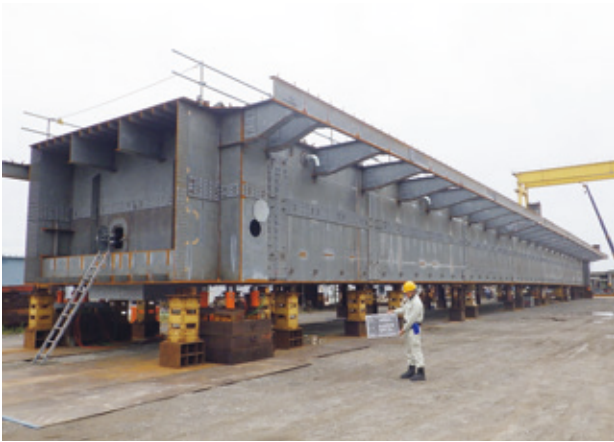
図-7 支点支持仮組立状況
