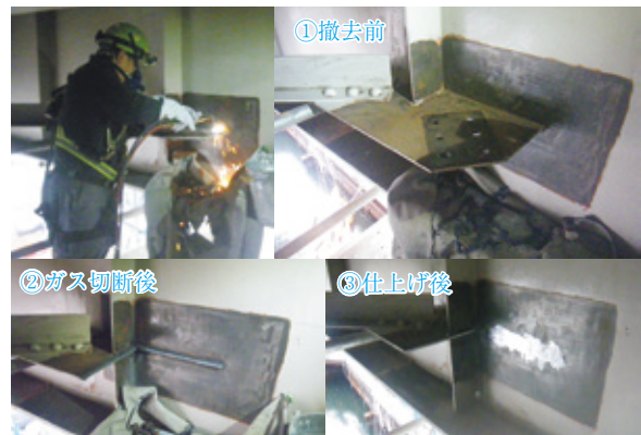
写真-3 既設ガセット撤去状況
