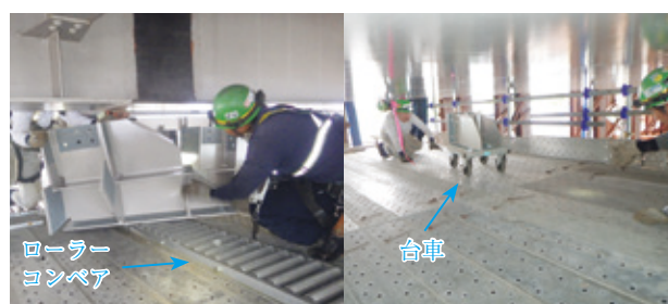
写真-5 足場内部部材移動状況
