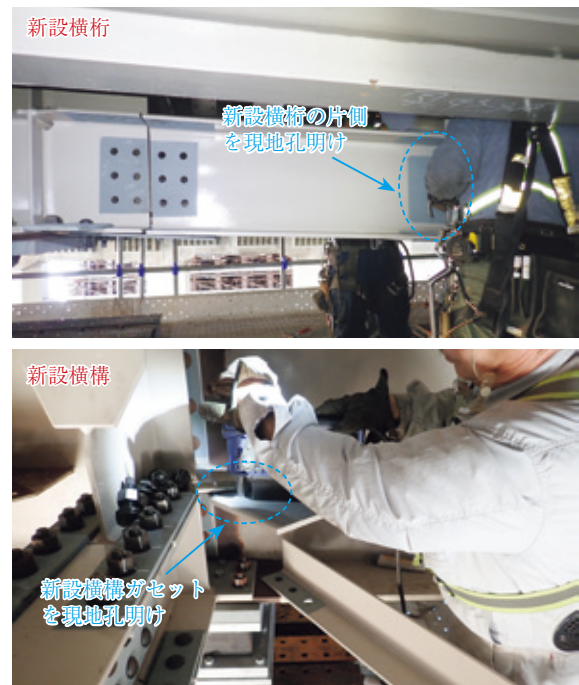
写真-8 主桁補強部材設置後状況
