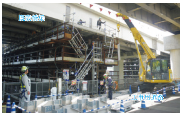
写真-4 部材搬入状況
