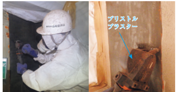
写真-2 塗膜剥離作業状況
