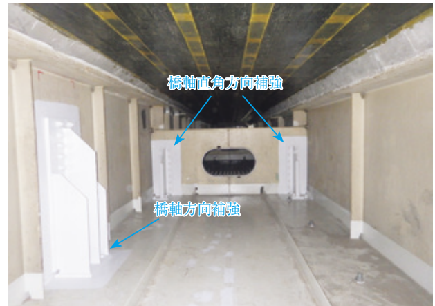
写真-13 補強部材設置完了 (箱桁部内面)
