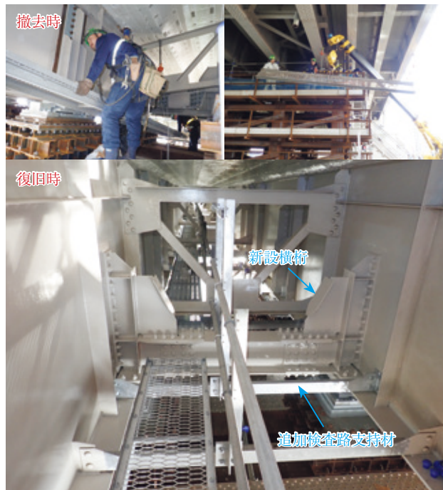
写真-10 検査路撤去復旧状況
