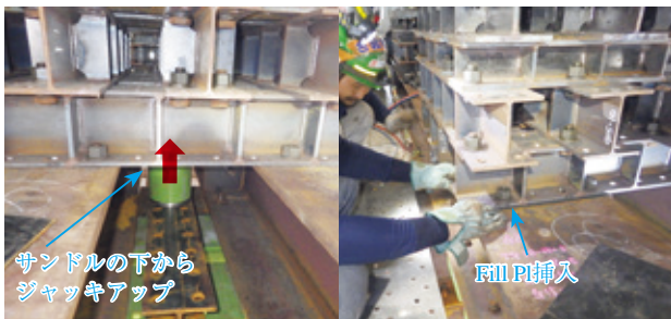
写真-9 支承施工状況
