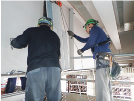
写真-6 部材設置状況
