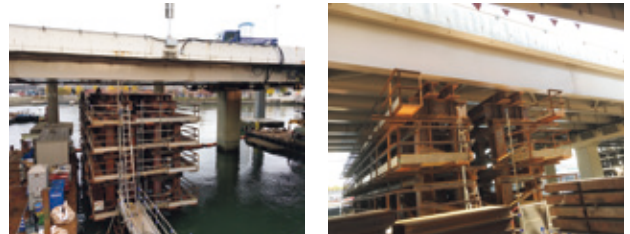
写真-1 支持杭打設状況
