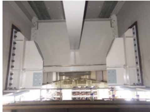
写真-7 部材設置状況
