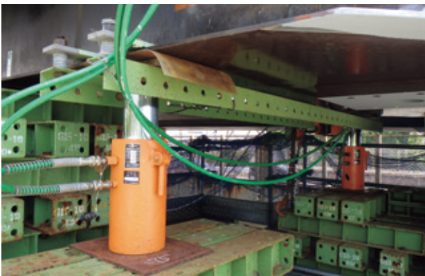
写真-16 桁降下ジャッキ
