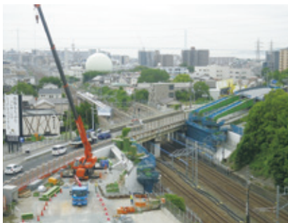
写真-2 送出し施工前
