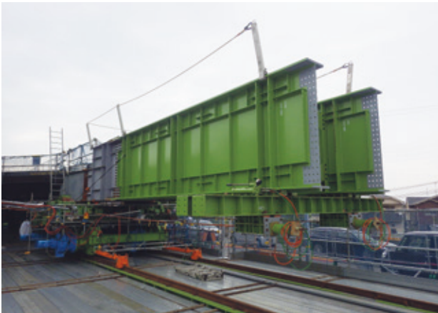
写真-12 台車と後方桁とを拘束
