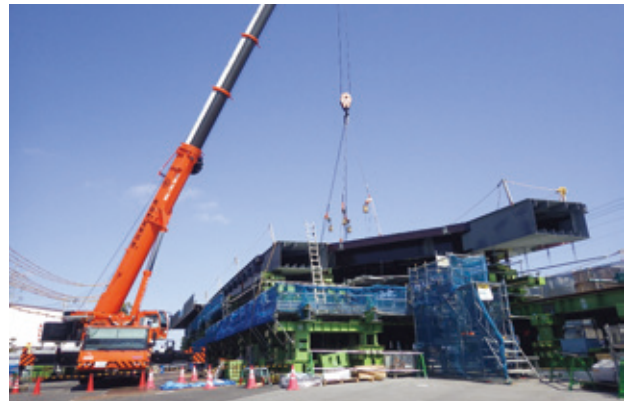
写真-8 主桁組立
