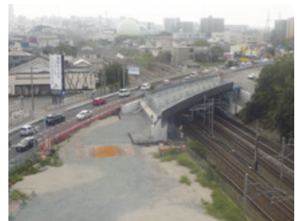
写真-4 桁架設完了
