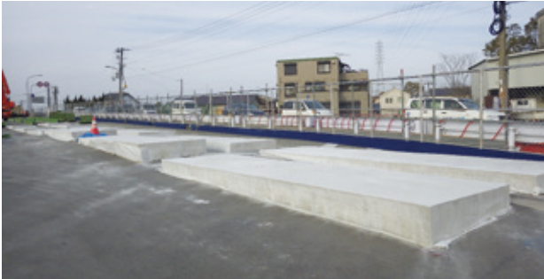
写真-5 鉄筋コンクリート基礎
