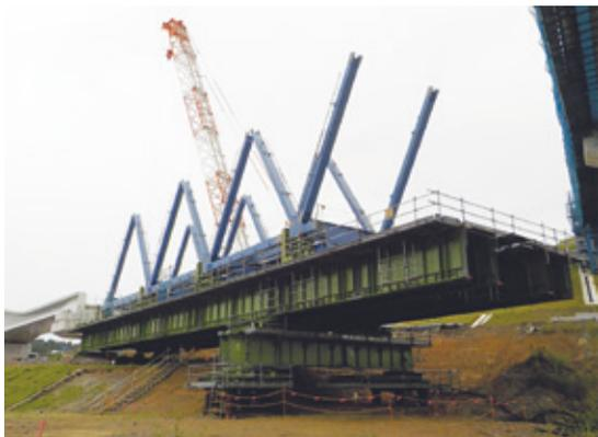
写真-10 2P-3P間トラス桁組立状況
