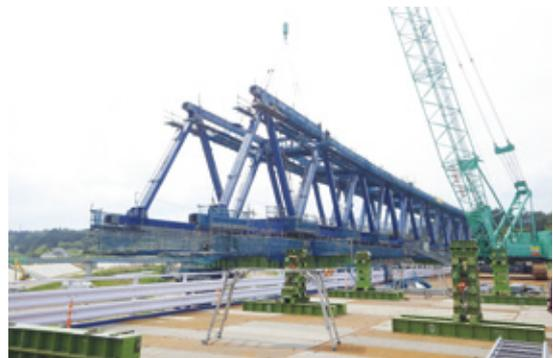
写真-6 3P-4P間 トラス桁架設
