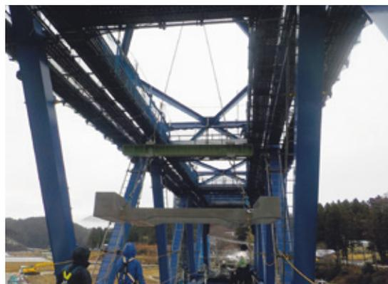
写真-14 プレキャスト床版クレーン架設状況
