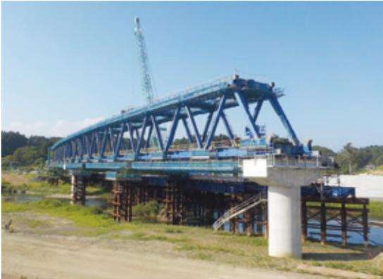
写真-7 3P-4P間 トラス桁架設完了
