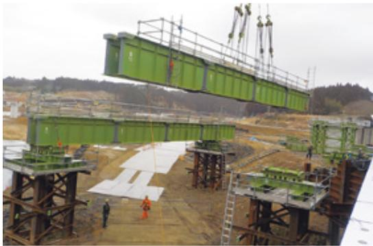
写真-1 4P-5P間 ベント上受桁組立状況
