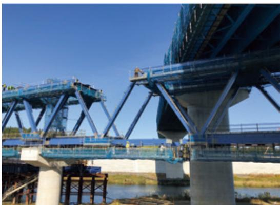
写真-12 下弦材・斜材閉合状況（縦取り作業中）
