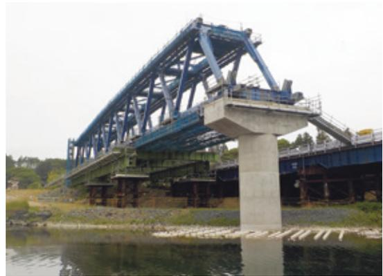
写真-4 4P-5P間 トラス桁組立完了
