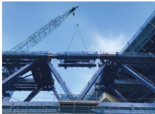
写真-13 上弦材閉合ブロック架設状況
