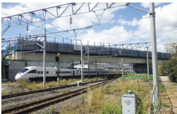
写真-12 桁降下完了（JR上状況）
