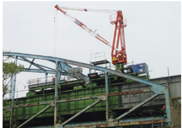
写真-8 ジブクレーン台車・架設桁上運搬台車
