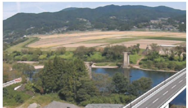
写真-17 撤去後全景
