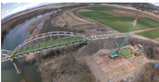
写真-7 架設桁の組立
