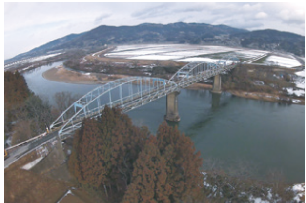
写真-1 旧柵の瀬橋全景
