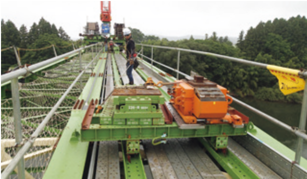
写真-14 手延機上運搬状況
