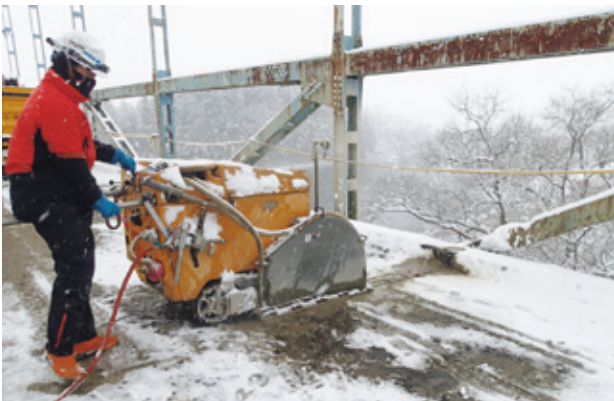
写真-3 床版カッター切断状況
