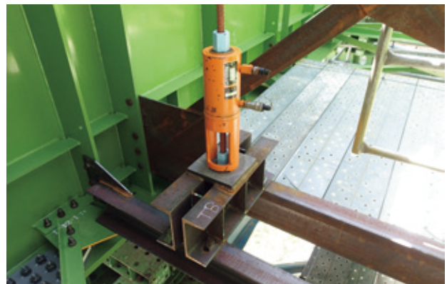
写真-9 吊り下げ設備
