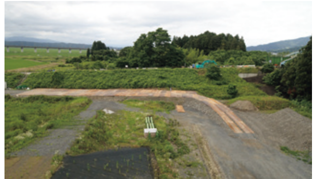
写真-16 クレーンヤード盛土 (A2)
