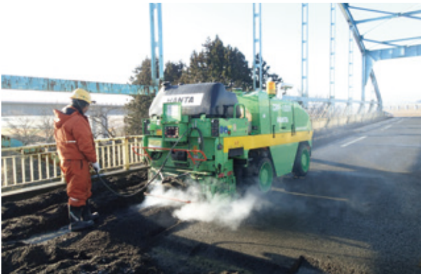
写真-2 アスファルト舗装撤去状況
