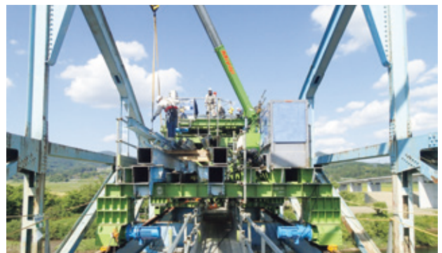
写真-12 撤去材運搬状況
