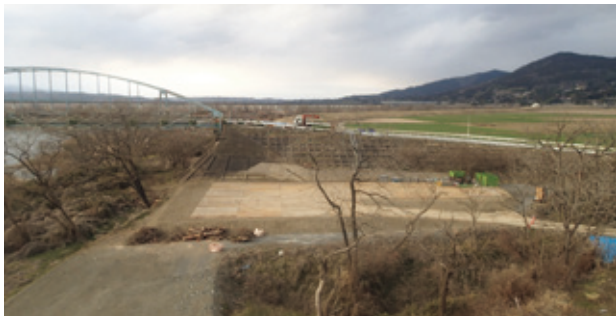
写真-6 クレーンヤード盛土 (A1)
