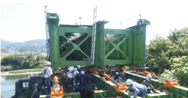
写真-15 架設桁引き戻し状況
