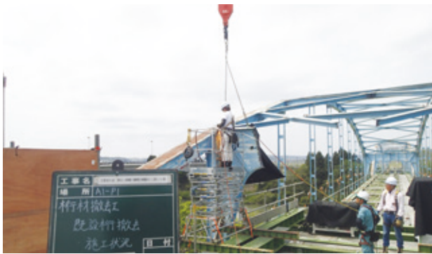
写真-10 ガス切断状況
