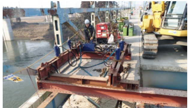
写真-4 床版ブロック撤去状況
