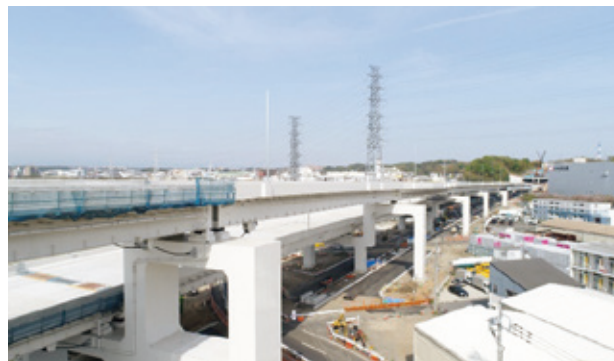
写真-8 完成写真（終点から起点）
