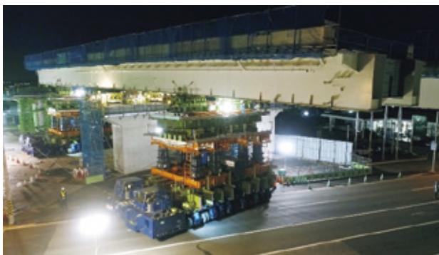
写真-5 縦送り作業中 (STEP-3)
