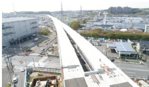
写真-7 完成写真（起点から終点）
