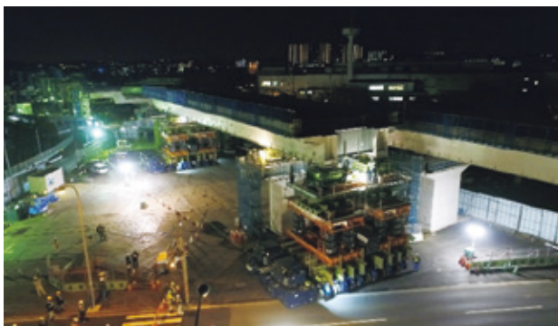
写真-4 縦送り作業中 (STEP-1)
