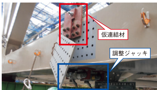
図-18 主桁添接部
