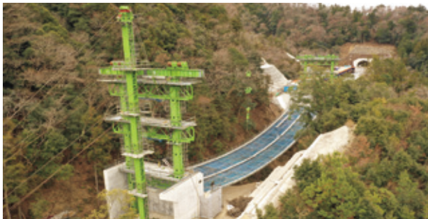
図-17 ケーブル設備完了
