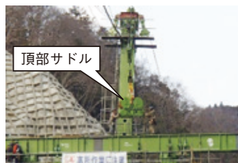
図-16 サドル設置
