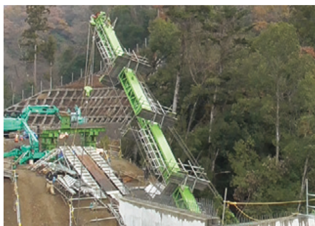
図-13 鉄塔建起こし
