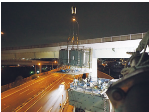
写真-6 本線上張出し鋼桁架設状況
