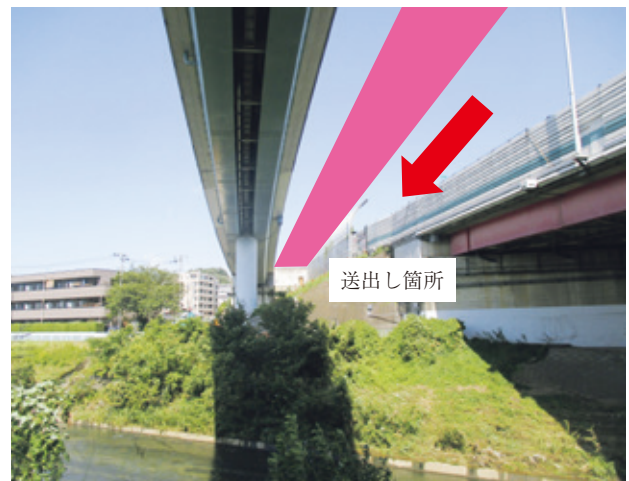
写真-8 送り出し施工前状況（送り出し方向）
