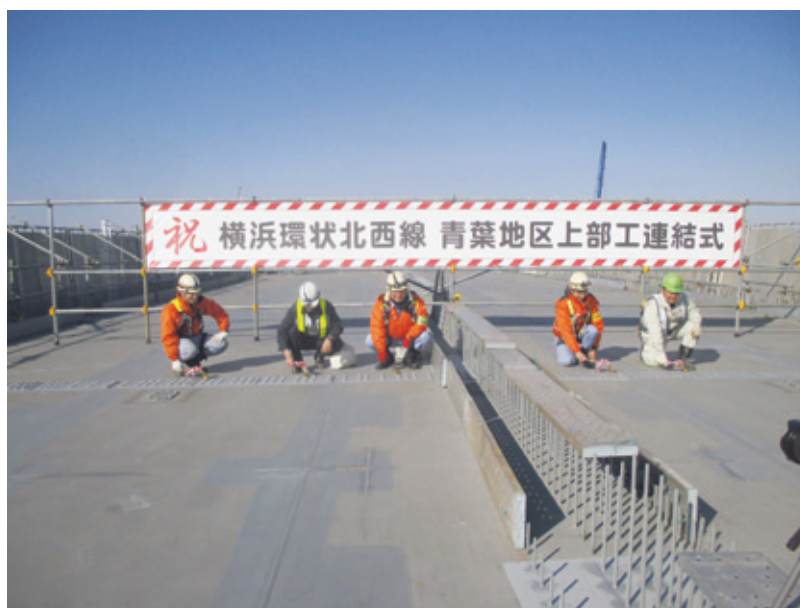
写真一17 横浜環状北西線青葉地区上部工連結式
