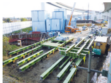
写真一3 杭基礎形式クレーン構台
