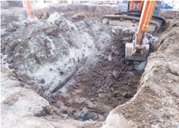
写真-4 表層改良状況
