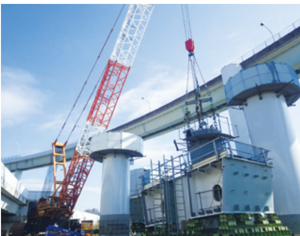
写真-5 柱基部ブロック試験吊り状況
