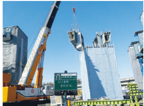
写真二 隅角部架設状況
