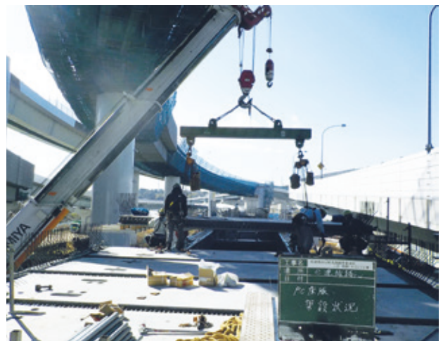
写真-15 吊天秤を使用したPC床版架設状況
