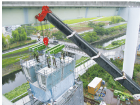
写真-7 ランプ下鋼桁架設状況
