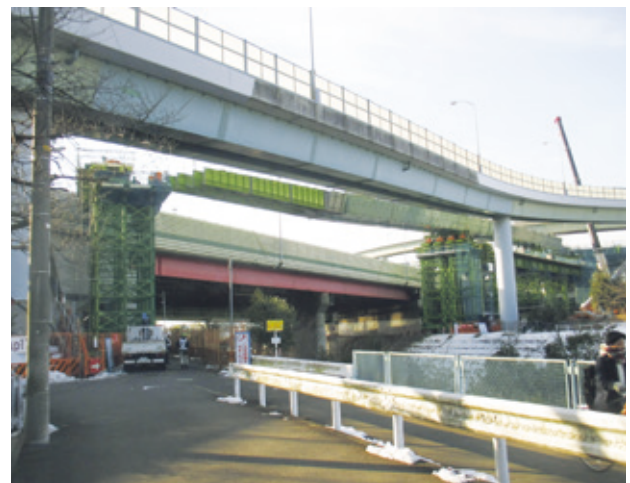
写真-10 B02到達前夜間架設前状況
