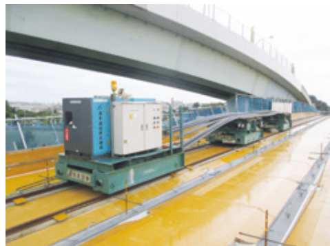
写真-12 運搬台車使用状況
