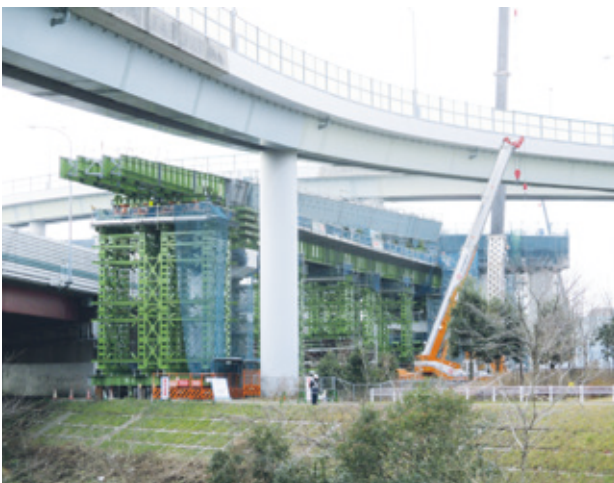
写真-9 B01到達後桁地組状況
