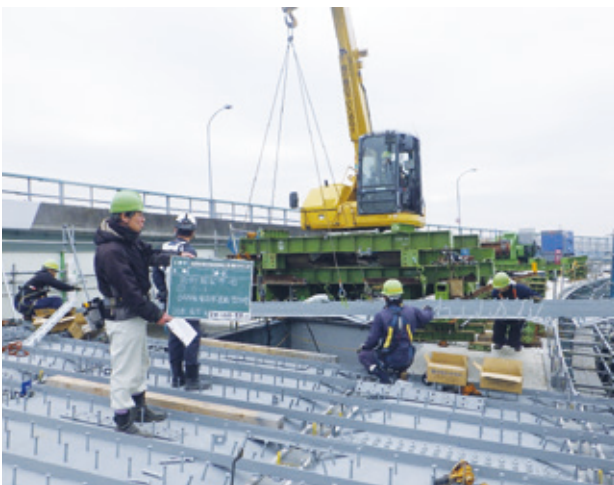
写真-14 架設機による合成床版架設状況
