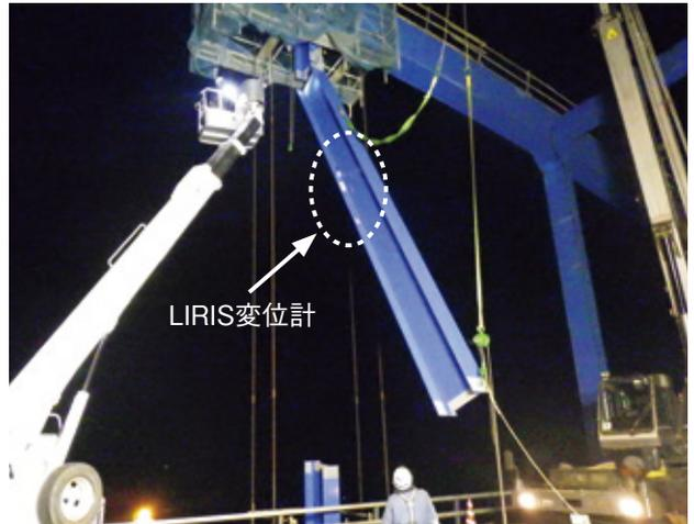
図-15 センサー設置状態での新設吊材の架設
