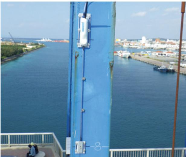
図-13 センサーが設置された既設吊材の腐状況
