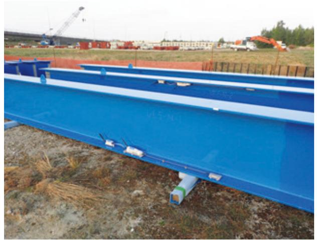
図-14 架設前の新設吊材へのセンサー設置状況
