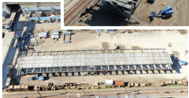
(宝町架道橋Bv仮組全景)
