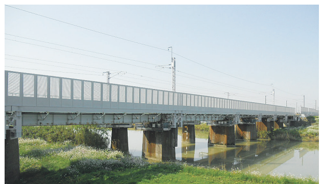
写真一8 防風柵設置完了（梯川橋梁部）
