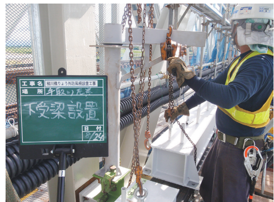
写真-15 受梁降下設備
