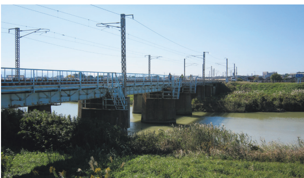
写真一4 防風柵設置前（梯川橋梁部）
