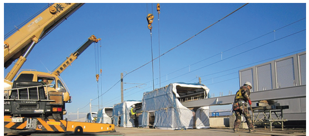
写真-18 受梁反転状況
