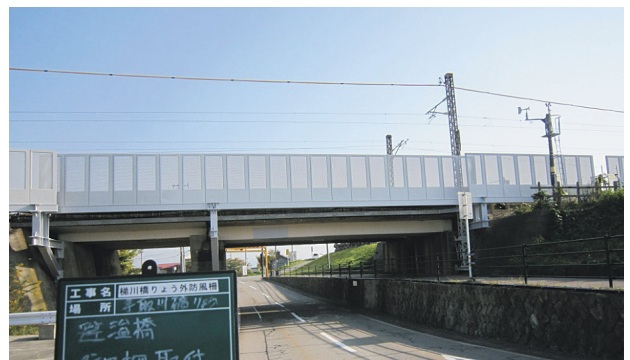
写真一7 防風柵設置完了（手取川避溢部）
