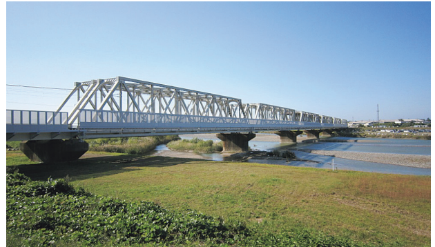
写真一5 防風柵設置完了（手取川下路トラス部）
