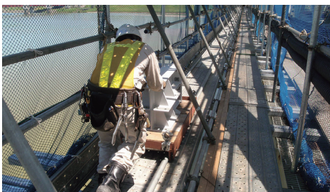
写真-12 台車運搬状況(ブラケット)
