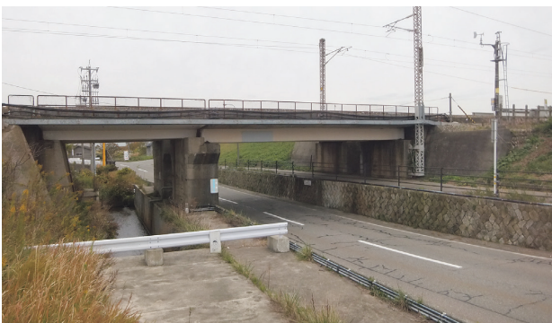
写真一3 防風柵設置前（手取川避溢部）
