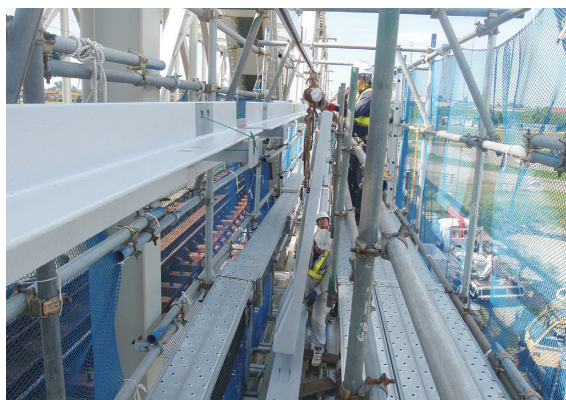
写真-17 FRP製防風柵設置
