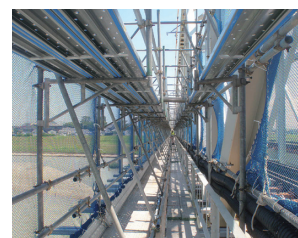
写真-10 張出し足場
