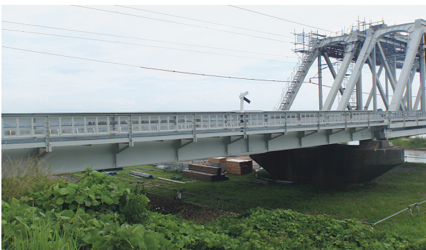
写真一2 防風柵設置前（手取川下路ガーダー部）
