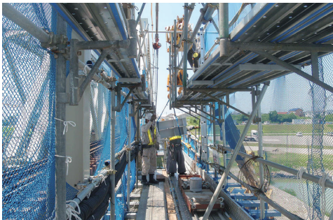
写真-11 材料荷揚げ
