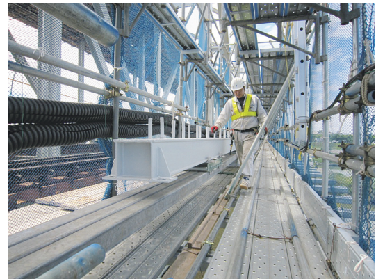
写真-14 台車運搬状況(下部受梁)
