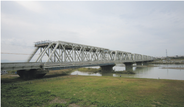
写真一1 防風柵設置前（手取川下路トラス部）
