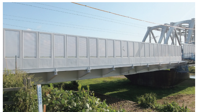
写真一6 防風柵設置完了（手取川下路ガーダー部）
