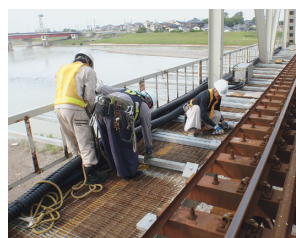
写真-9 張出し角鋼管
