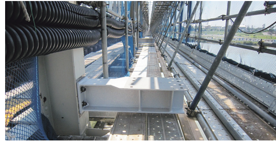
写真-13 ブラケット設置
