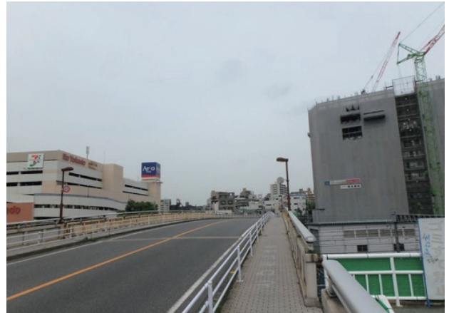
写真-1 施工前橋面状況
