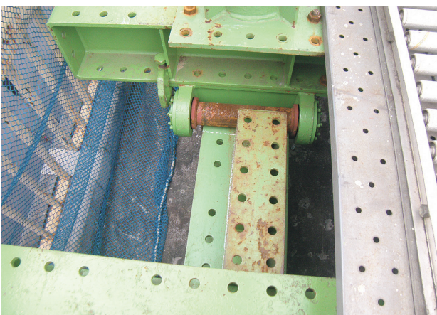
写真-8 ストッパー設置状況
