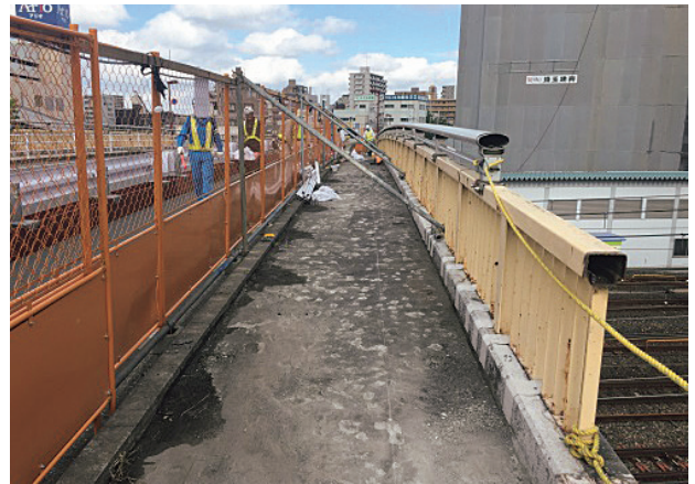
写真-2 常設規制帯内状況
