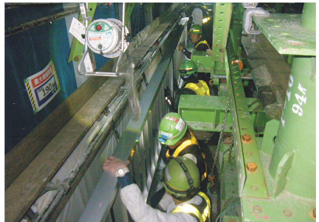
写真-16 鋼製高欄設置状況
