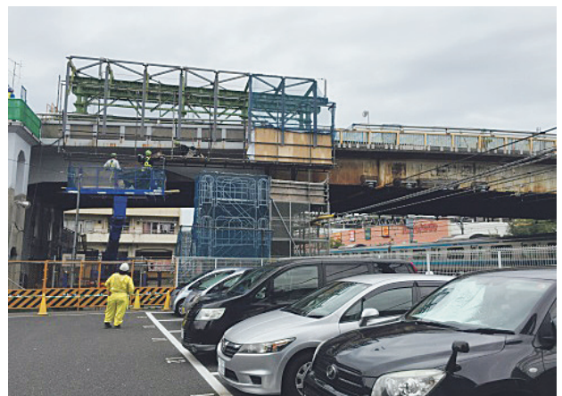
写真-6 外面足場組立状況
