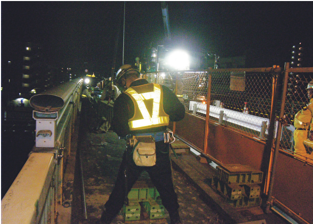
写真-3 軌条梁設置状況
