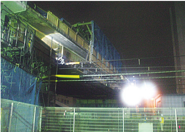
写真-7 移動式足場縦取り状況
