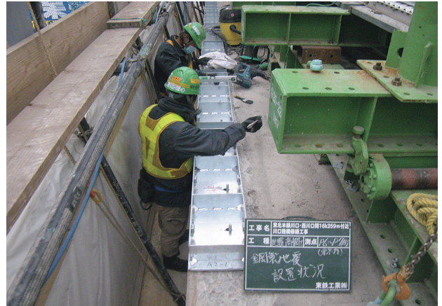
写真-14 鋼製地覆設置状況
