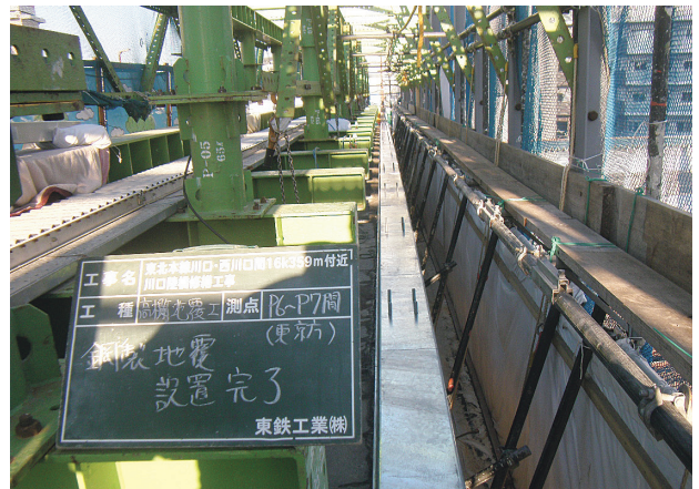
写真-15 鋼製地覆設置完了
