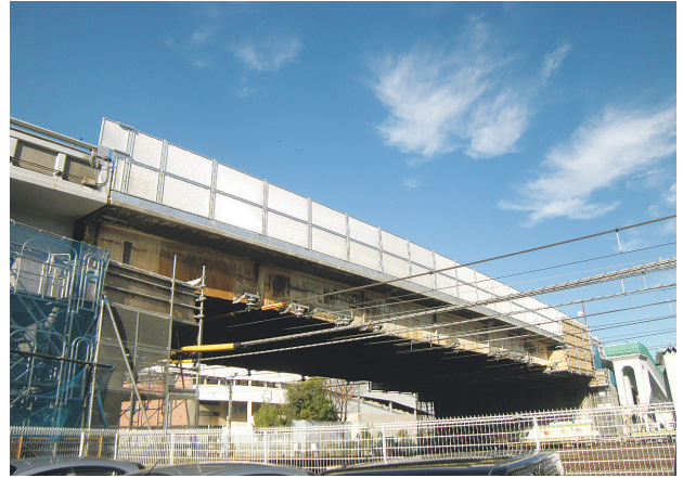
写真二十 高欄・地覆取替え完了
