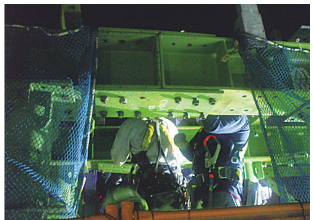
写真-11 足場連結状況
