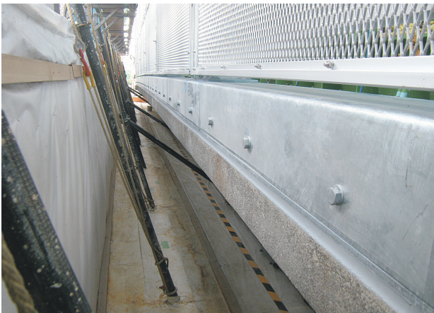
写真一八 鋼製地覆・高欄通り状況
