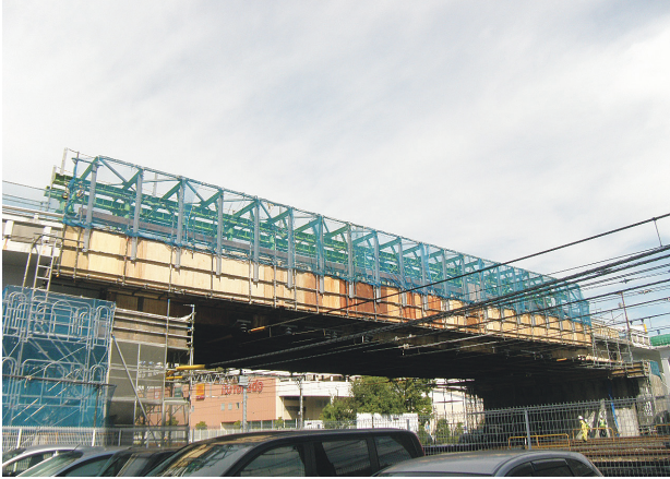
写真-12 移動式足場設置完了
