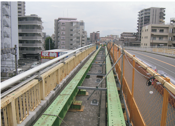
写真-4 軌条梁設置完了
