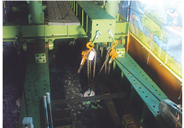
写真-9 移動式足場固定状況
