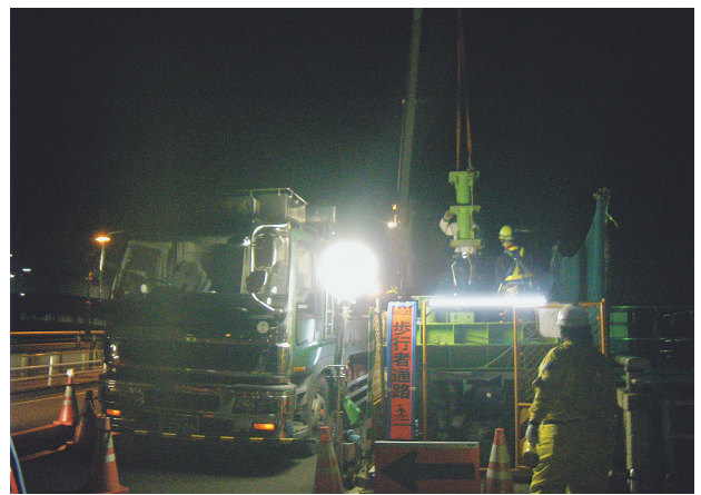
写真-5 移動式足場ベント組立状況
