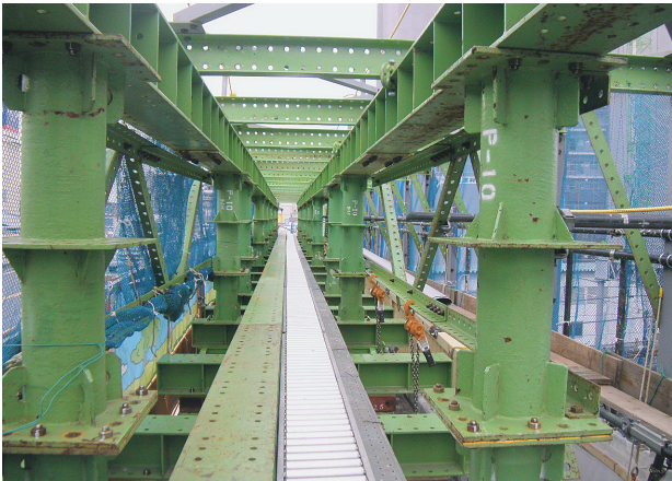
写真-13 足場内設備
