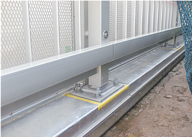
写真一七 鋼製高欄基部状況
