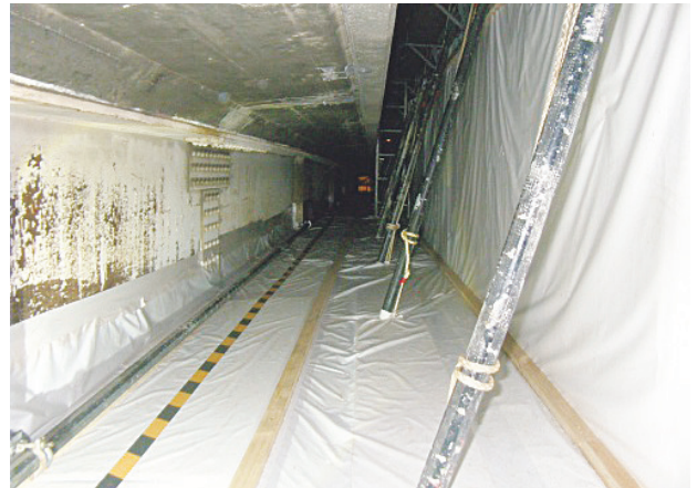
写真-10 足場内養生状況
