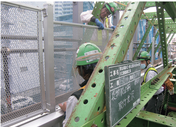
写真一十九 投物防止柵取付状況
