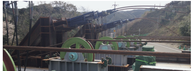
写真-20 補助ジャッキと方向転回シープ
