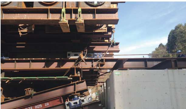
写真-23 水平移動部ジョイント完了
