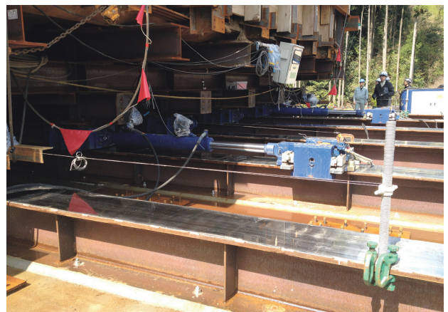
写真-27 H鋼クランプジャッキでの水平移動
