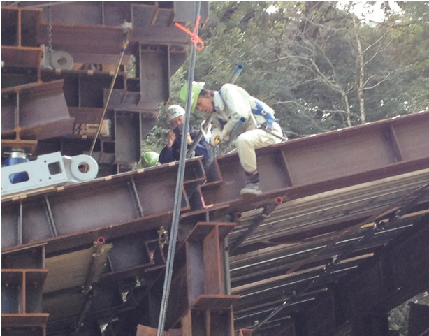
写真-16 斜路軌条と1号架台軌条部の接合
