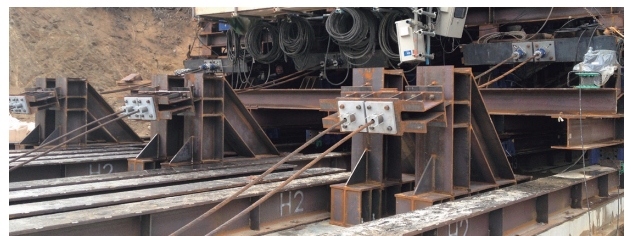
写真-21 補助ジャッキPC鋼より線下部合い
