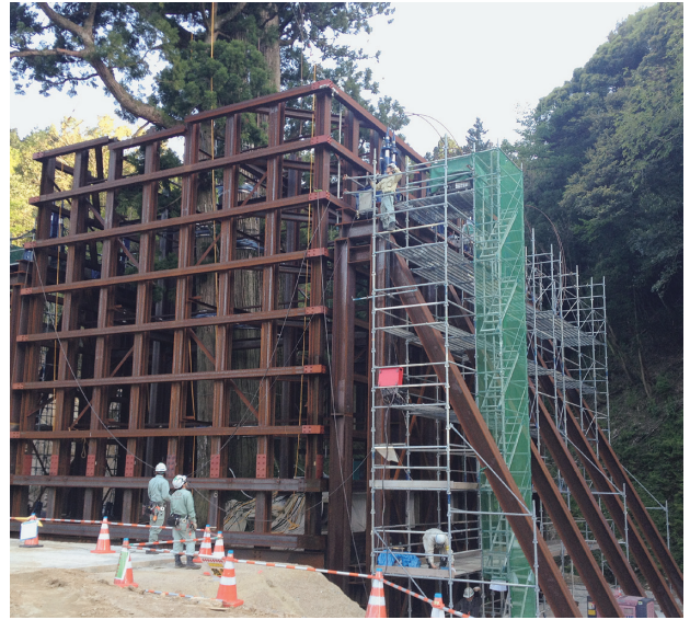
写真-30 ジャッキダウン完了
