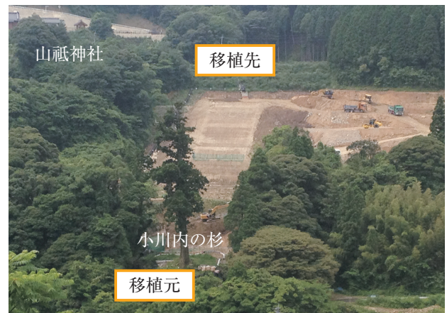
写真-2 工事全景
