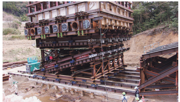
写真-14 吊り上げ用構台撤去
