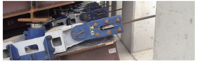
写真-19 引き上げ用ストランド取り合い（架台側）
