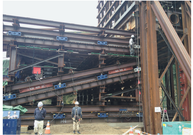
写真-12 移動架台横移動
