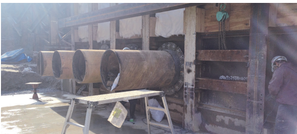
写真-4 パイプルーフ打ち込み後
