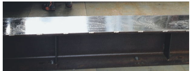
写真-13 移動軌条梁
