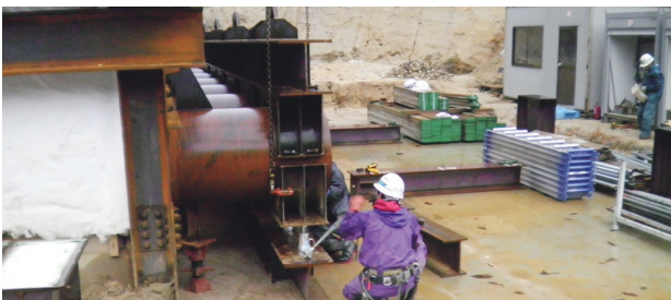
写真-5 パイプルーフ受梁取り付け
