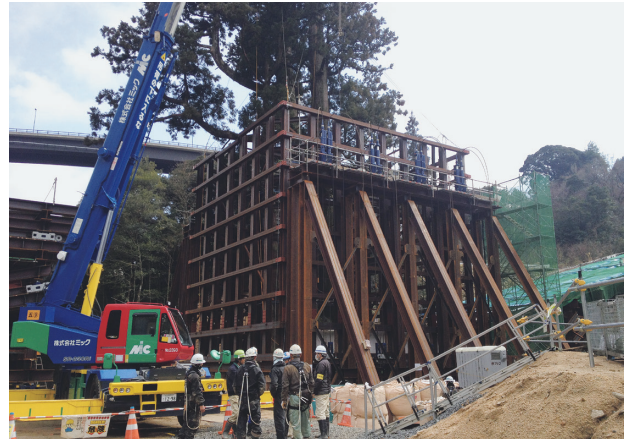
写真-6 ジャッキアップ架台（移植元）
