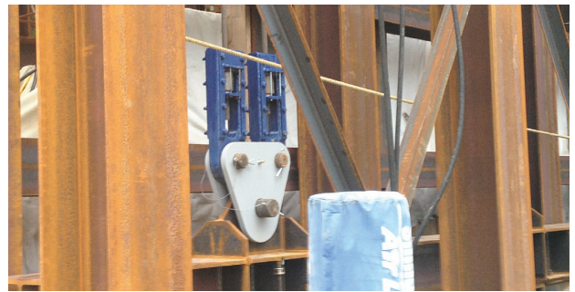
写真-7 リフトアップ吊り点
