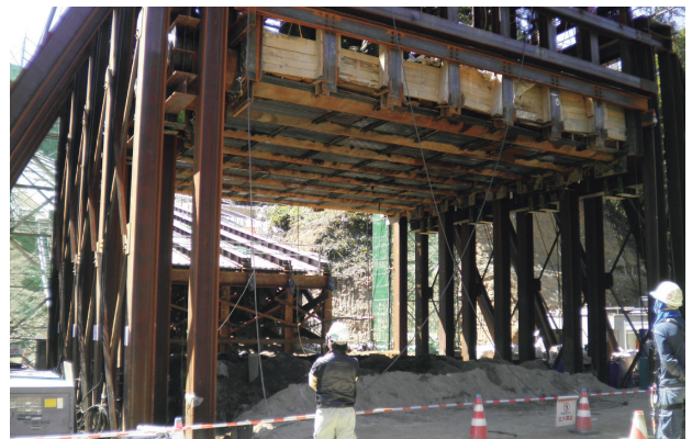
写真-9 ジャッキアップ完了（移植元）
