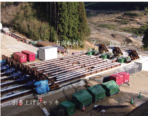
写真-17 引き上げ設備配置
