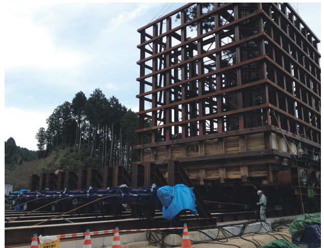
写真-26 PC鋼より線での水平移動完了
