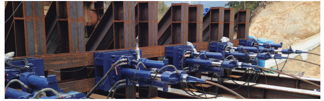
写真-18 引き上げジャッキ
