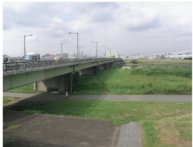
写真-13 施工前 江北橋 P14橋脚からP12橋脚
