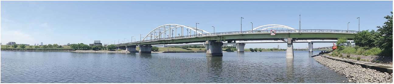
写真-10 江北橋全景（施工完了）
