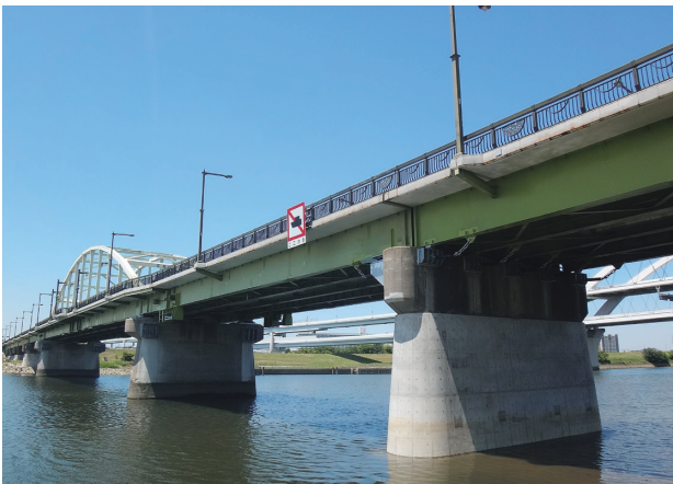
写真-12 完成 江北橋 P11橋脚からP9橋脚
