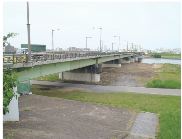
写真-14 完成 江北橋 P14橋脚からP12橋脚
