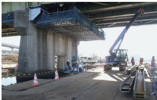
写真-3 P11橋脚 仮締切状況（サイレントパイラー使用）
