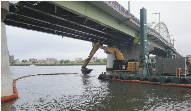
写真一六 バックホウ台船による浚渫状況
