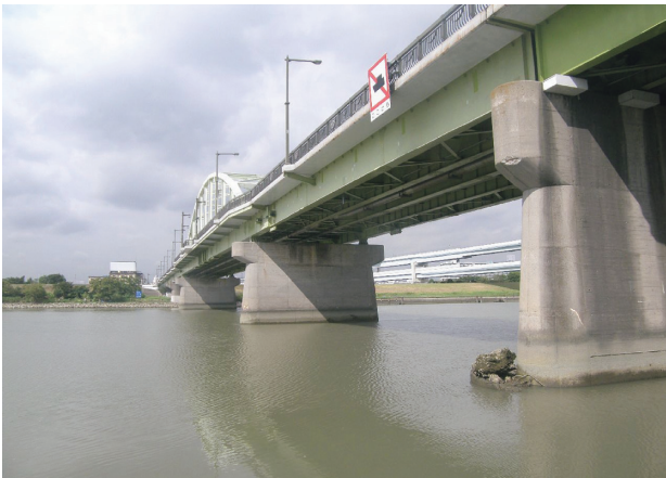
写真-11 施工前 江北橋 P11橋脚からP9橋脚
