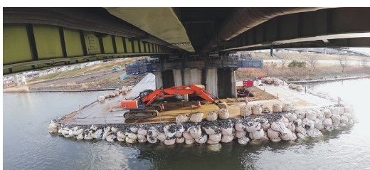
写真-4 P11橋脚 仮締切完了
