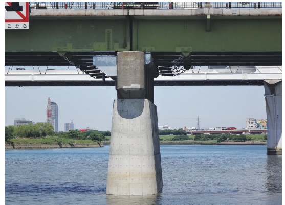
写真-1 P11橋脚 耐震補強完了
