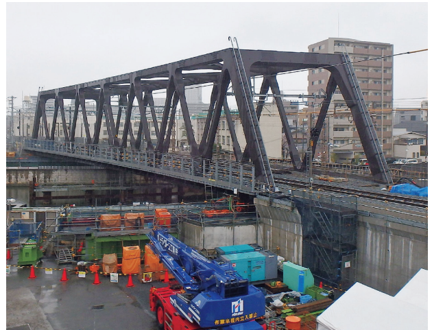
写真-11 横取り完了
