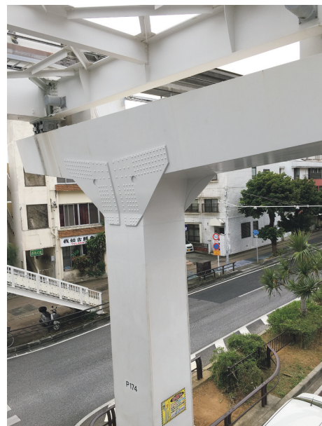
写真一15 P174橋脚（補強後）
