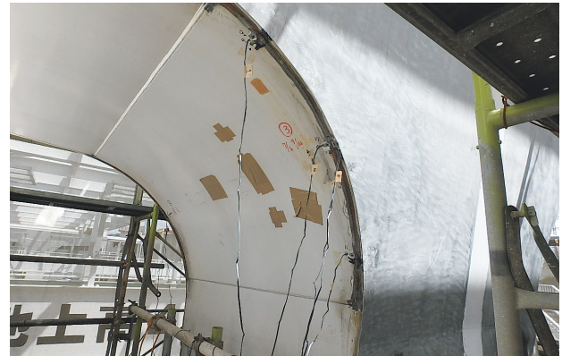
写真-11 ひずみゲージ取付状況
