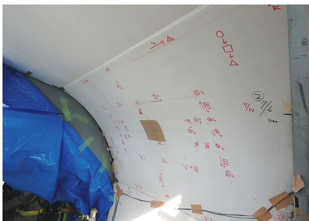
写真-4 カバープレート撤去前状況
