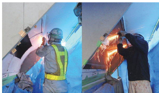
写真-7 施工STEP-3作業状況
