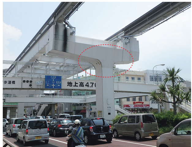
写真-1 P174橋脚（補強前）
