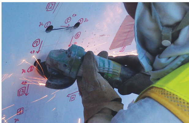
写真-5 施工STEP-1作業状況
