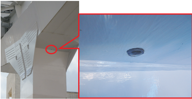
写真-13 水抜孔設置箇所
