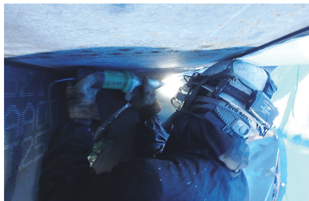
写真-8 施工STEP-4作業状況
