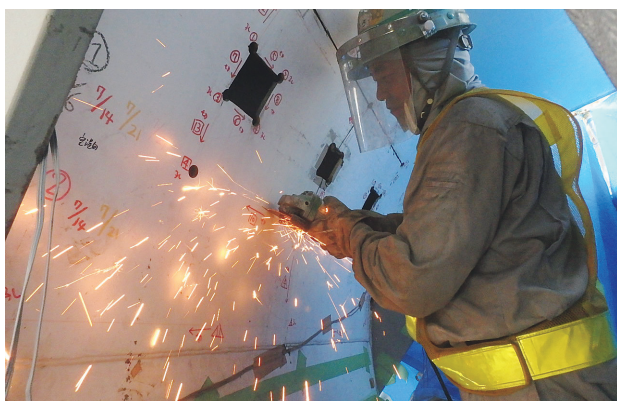
写真-6 施工STEP-2作業状況
