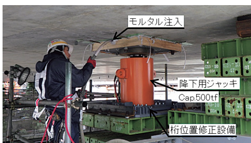
写真-6 降下用ジャッキ取付け状況
