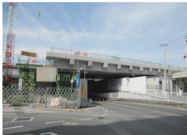
写真-11 PC桁ジャッキダウン完了後全景
