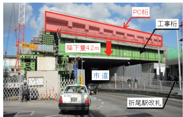
写真-1 主桁ジャッキダウン全景
