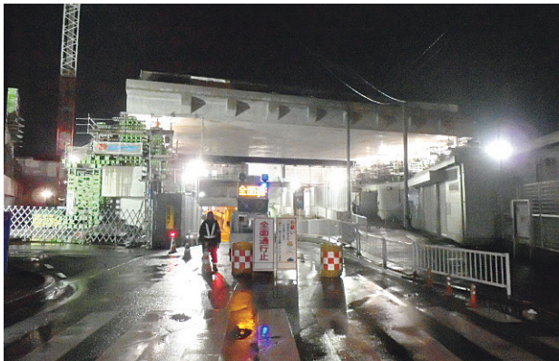
写真-10 夜間ジャッキダウン状況
