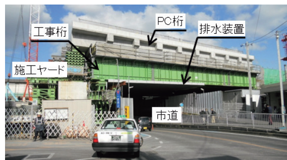
写真-5 工事桁下面排水装置設置全景
