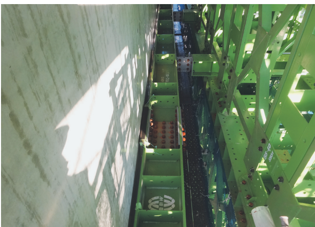
写真-12 クロロプレングム設置状況
