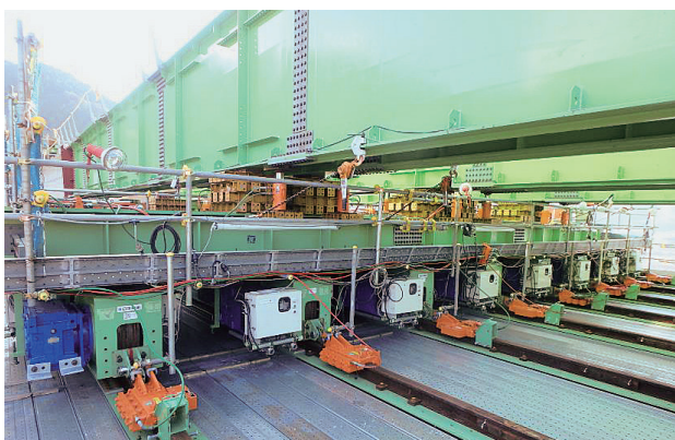
写真-8 前方台車設備
