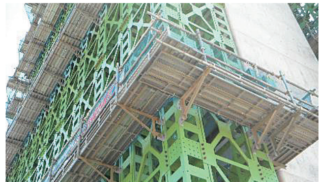
写真-1 BR-1・BR-S1を使用したベント足場
