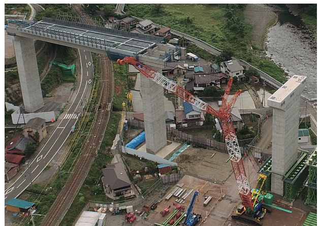
写真-19 完成全景(上空)
