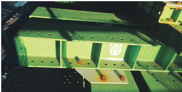
写真-6 ボルト取り付け調整プレート
