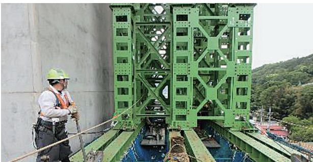
写真-17 ベント横取り状況
