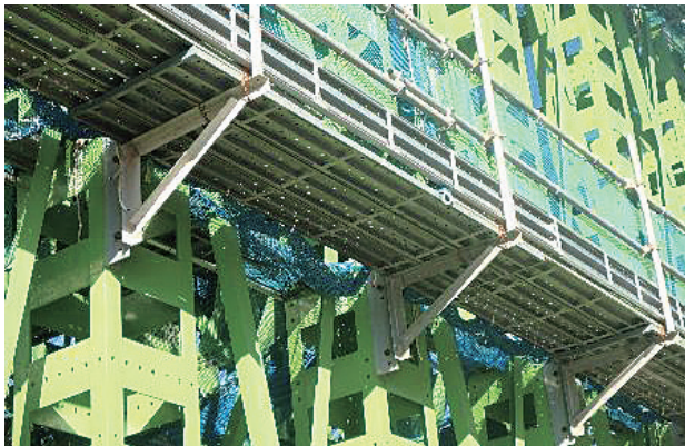
写真-3 BR-1・BR-S2を使用したベント足場
