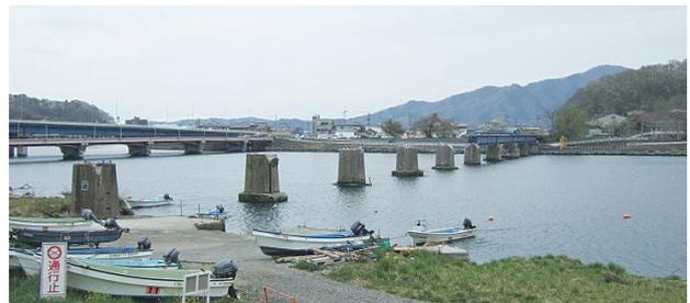
写真-1 盛岡方桁流失状況
