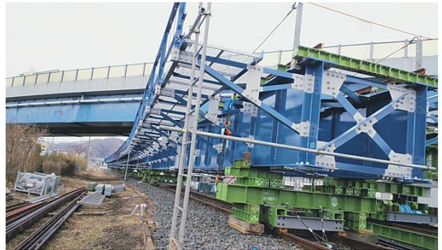
写真-3 新桁地組・仮置状況
