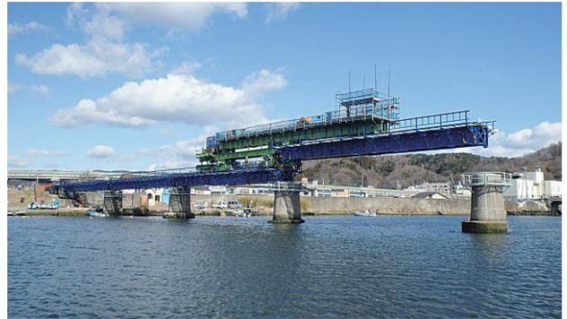
写真一七 G4桁架設状況
