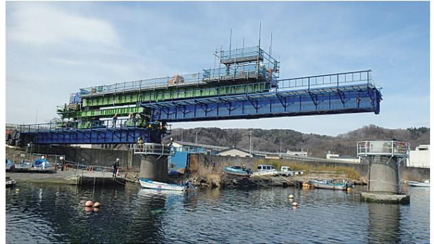
写真一五 G2桁架設状況
