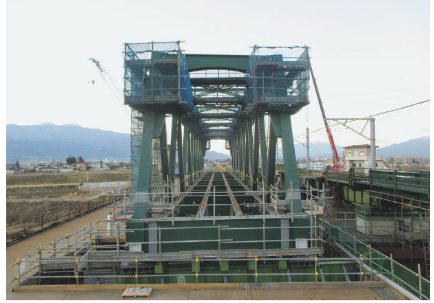
写真-11 トラス桁地組完了
