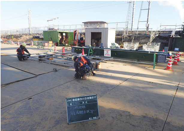
写真-9 上弦材吊足場地組
