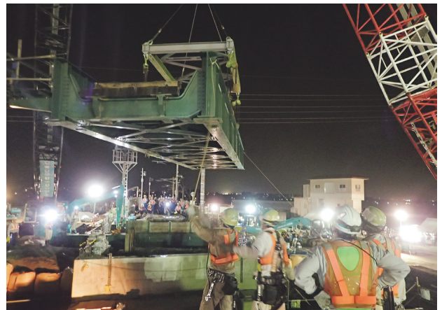
写真-22 A2工事桁撤去
