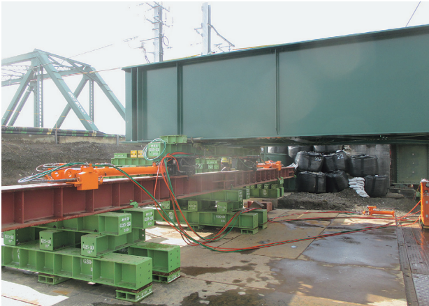
写真-3 横取ジャッキ
