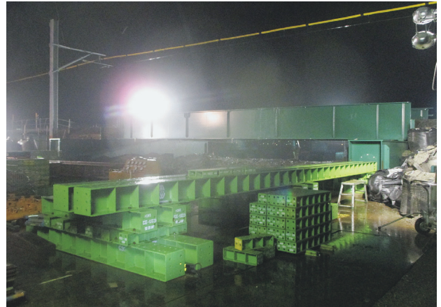
写真-6 A2工事桁架設完了
