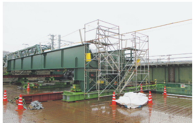
写真-2 A1工事桁地組完了
