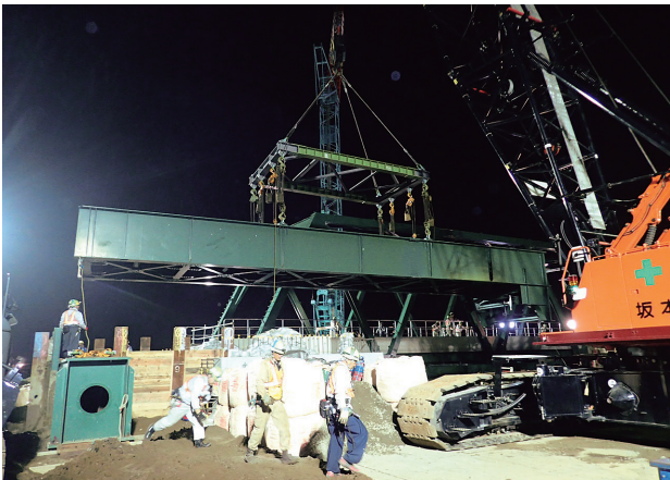
写真-20 A1工事桁撤去
