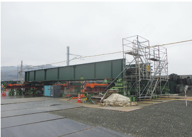
写真-5 A2工事桁地組完了
