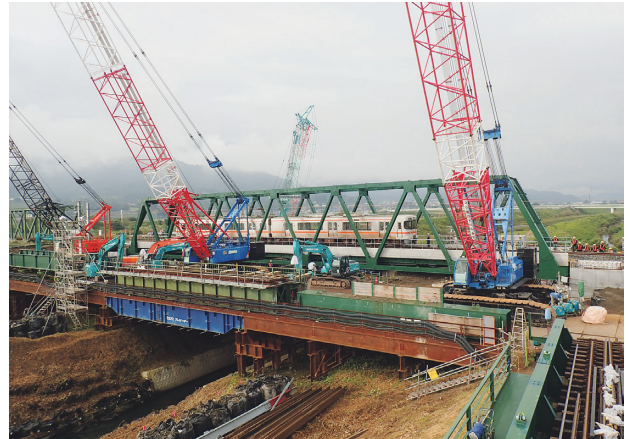
写真-26 トラス桁架設完了
