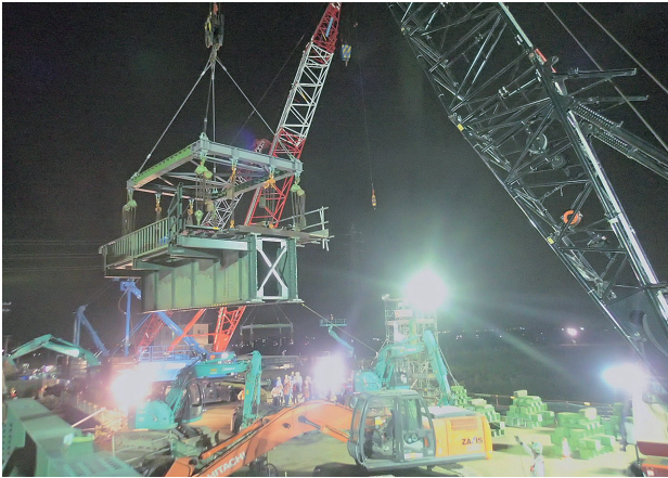
写真-18 今川橋りょう撤去
