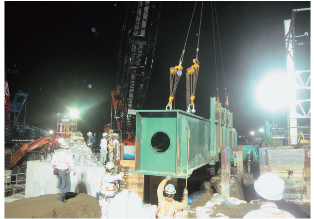
写真-21 A1受桁撤去
