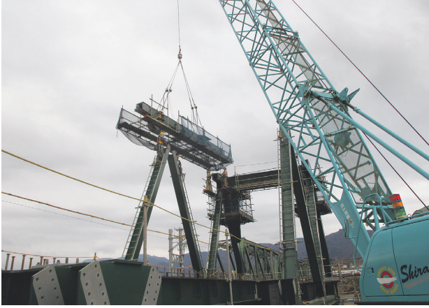
写真-8 タラップ使用状況
