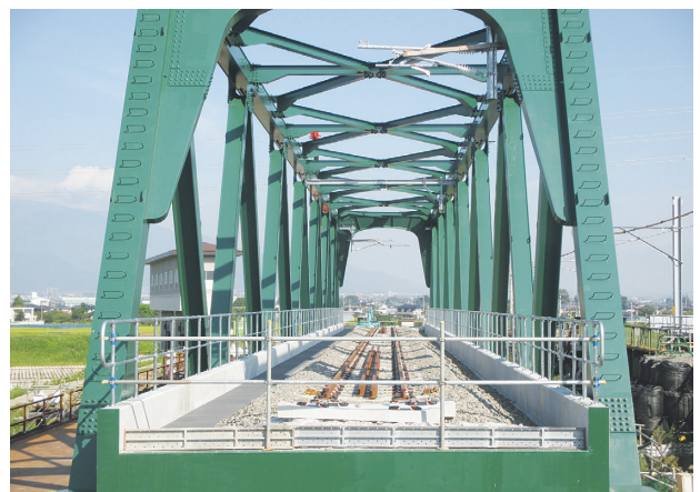
写真-13 軌道設置完了
