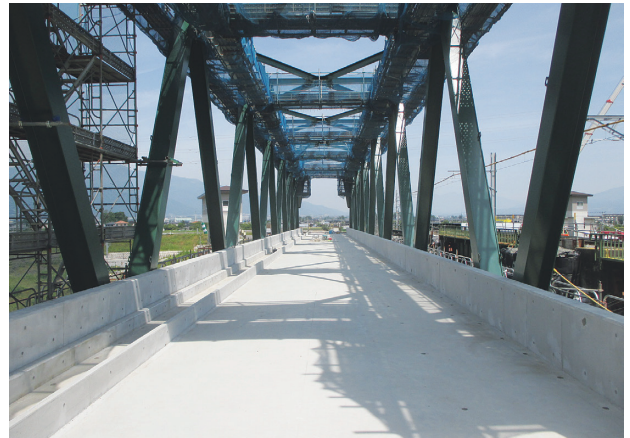
写真-12 床版打設完了
