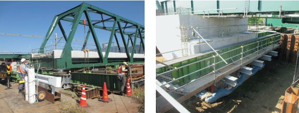
写真-14 軌条桁設置
