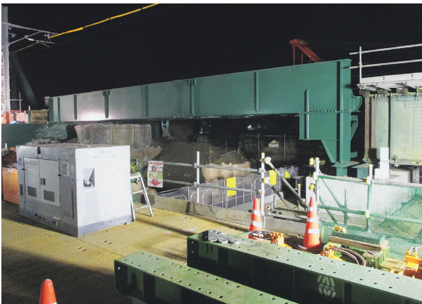
写真-4 A1工事桁架設完了
