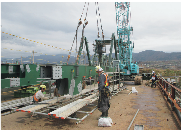
写真-10 上弦材吊足場地組
