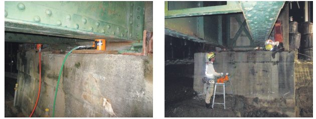
写真-16 既設桁縁切り確認
