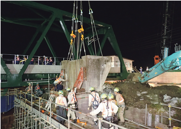
写真-24 既設橋台撤去
