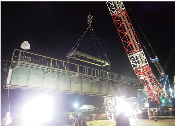
写真-19 早壺川橋りょう撤去
