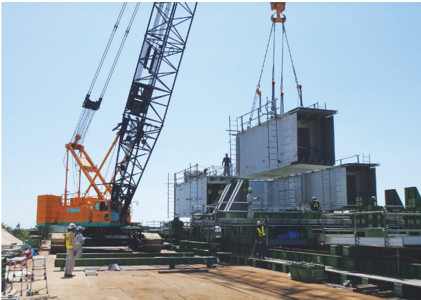
写真一1 桁組立状況
