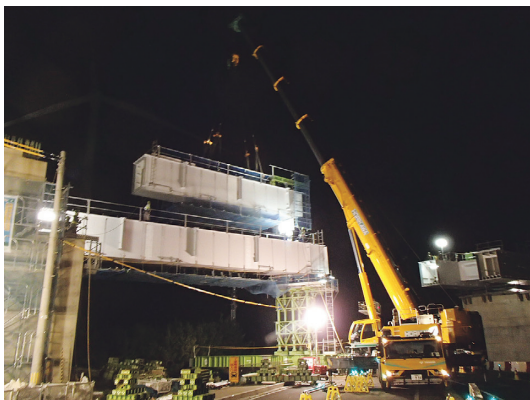
写真-8 架設状況写真
