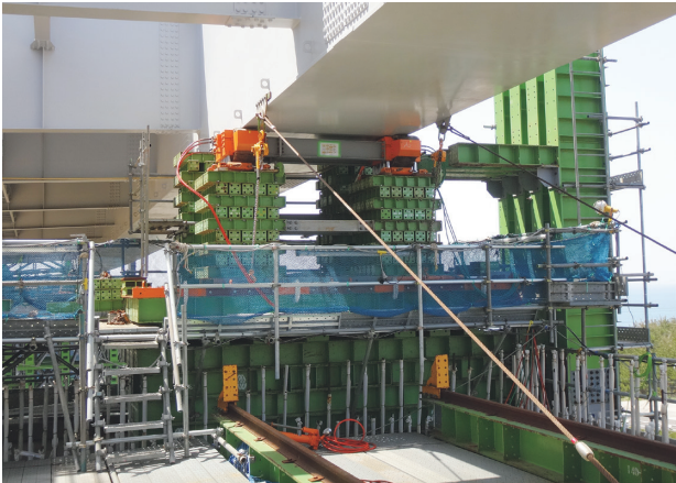
写真一5 シンクロジャッキ高さ調整
