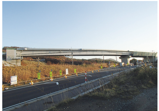
写真-9 架設完了
