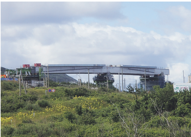
写真一6 送り出し完了
