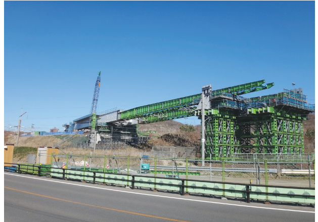
写真一3 第1回送り出し完了
