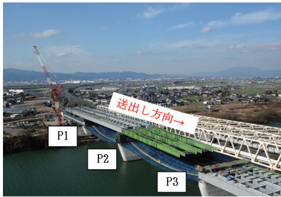
写真-9 送出し架設状況
