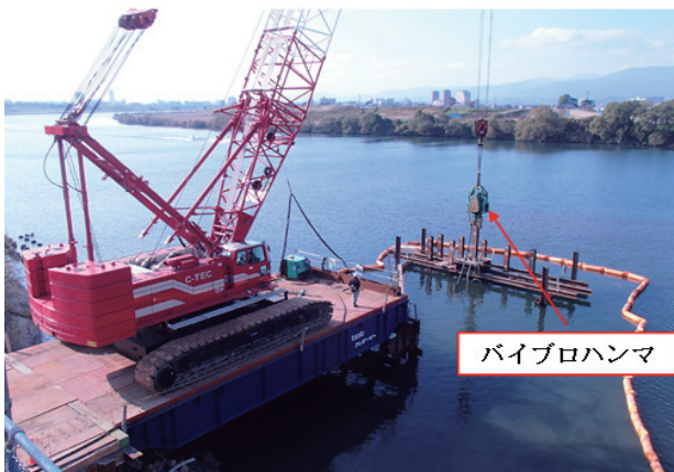
写真-3 仮棧橋施工状況
