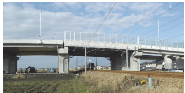
写真-2 北陸本線 針原こ線橋新設工事（PC道路橋）
