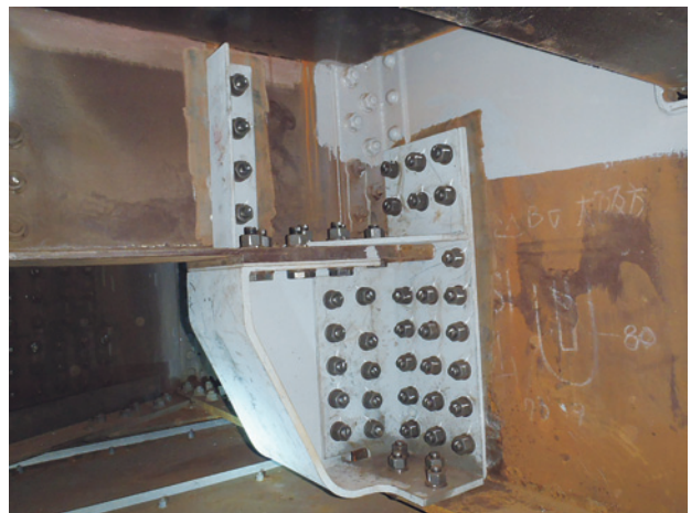
写真-1 床組接合部補強状況
