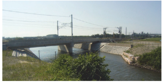
写真-4 北陸本線 黒瀬川橋りょう架替工事（鉄道橋）
