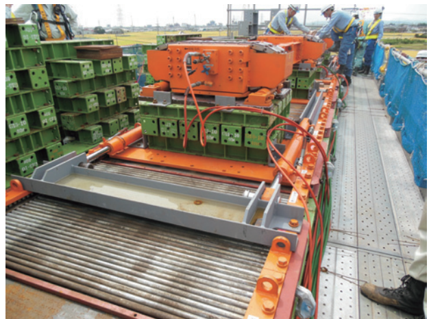
写真-3 シンクロジャッキ+ジャスコロ設備
