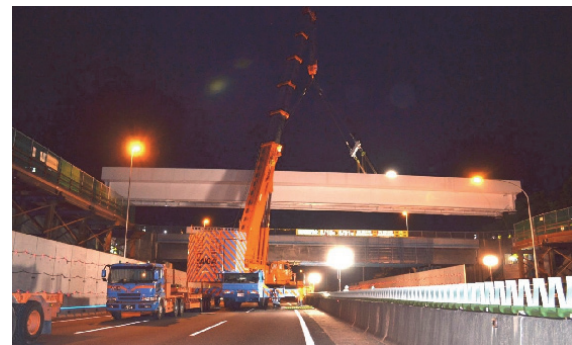
写真-4 安満跨道橋の夜間一括架設
