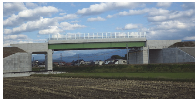
写真-1 北陸本線 経田こ線橋新設工事（鋼道路橋）
