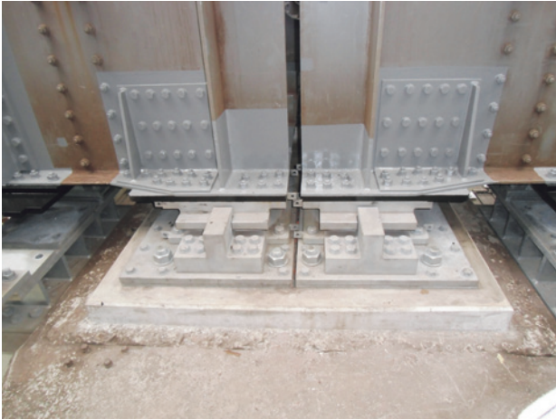
写真-2 支承部取替・補強状況
