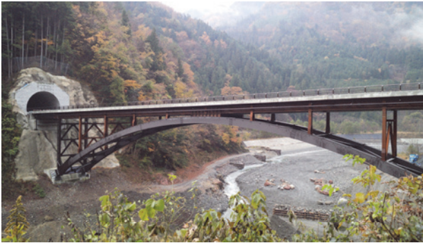
写真-1 橋梁全景
