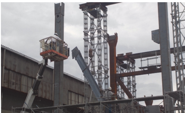
写真-2 倒立一体仮組立状況①
