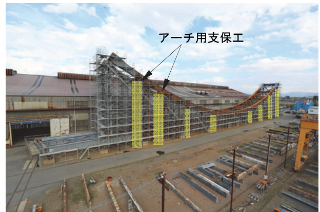
写真-4 倒立一体仮組立完了状況
