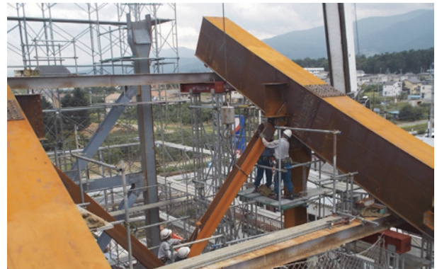
写真-3 倒立一体仮組立状況②
