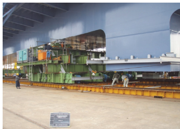
写真-1 自走台車による移動
