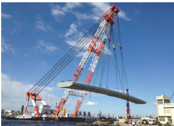
写真-4 伊良部大橋 主航路橋梁
