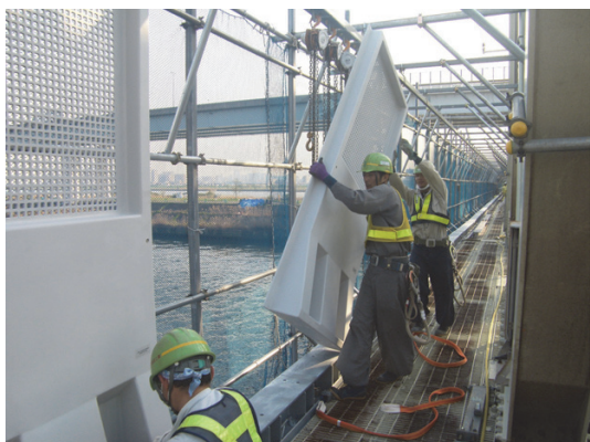
写真一5 FRP防風柵運搬時
