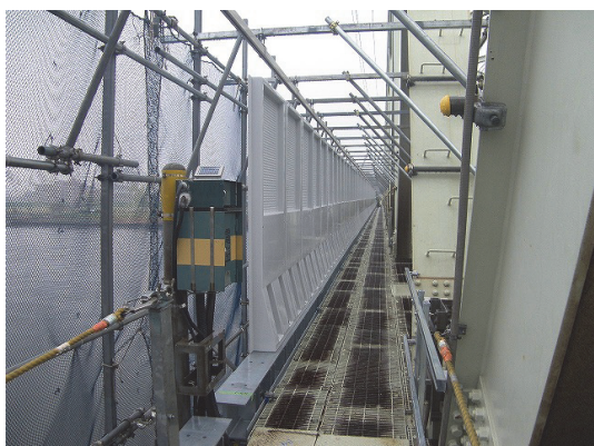
写真一6 FRP防風柵設置完了
