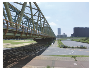
写真-1 設置前（江戸川橋梁）
