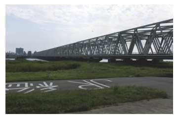
写真-3 設置前（荒川橋梁）
