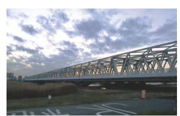
写真-4 設置後（荒川橋梁）
