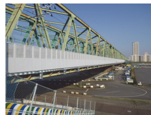
写真-2 設置後（江戸川橋梁）
