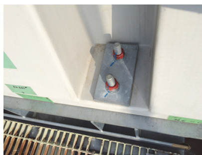
写真一9 FRP防風柵取付けボルト状況
