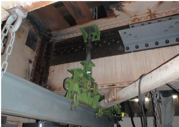
写真-15 既設上フランジ回転撤去設備
