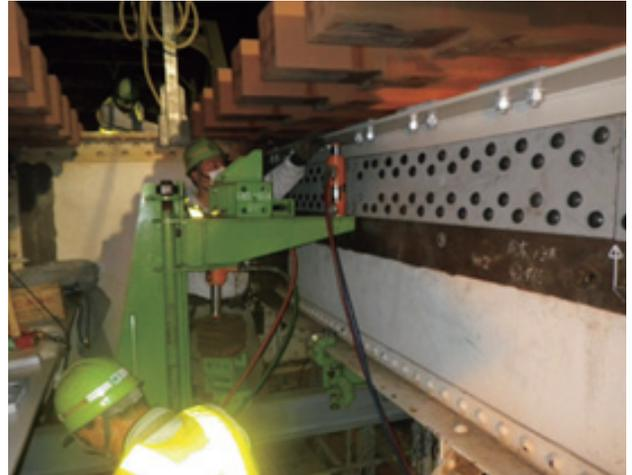
写真-14 新規T型フランジ設置完了
