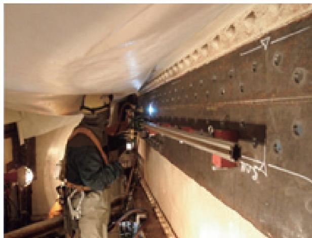
写真-6 腹板水平切断
