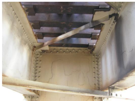
写真-2 縦桁上フランジ損傷状況
