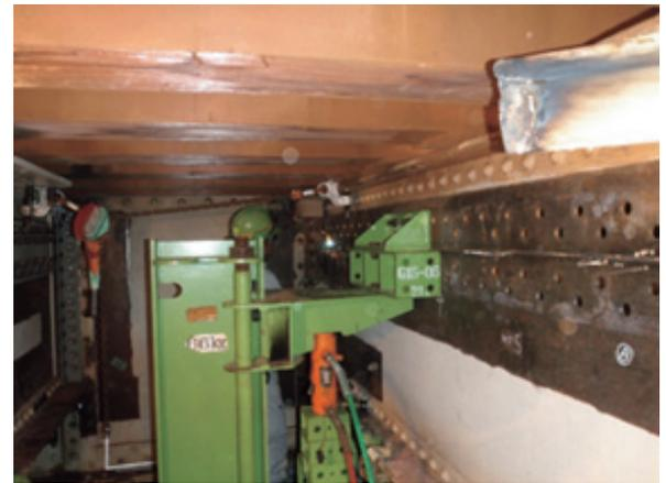
写真-9 添接板撤去～既設フランジ固定
