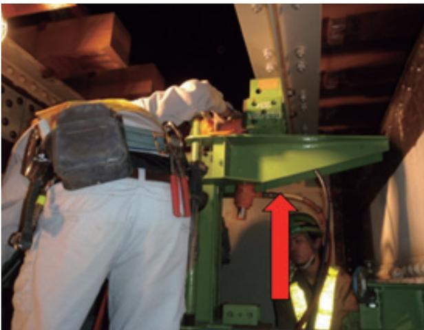
写真-12 新規T型フランジ扛上
