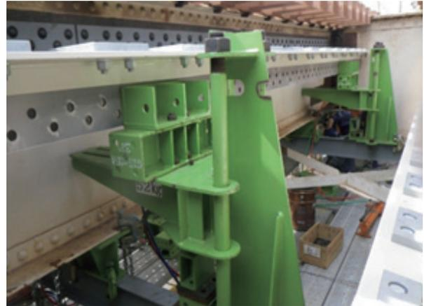
写真-8 上フランジ交換準備完了
