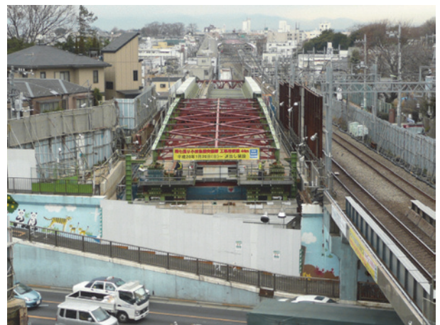
写真-2 送出し前の全景
