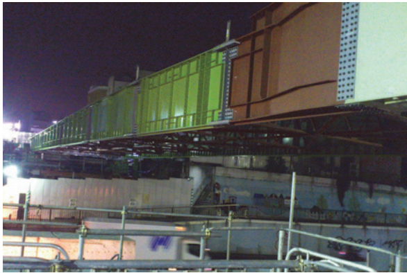
写真-7 環七を跨ぐ手延べ機
