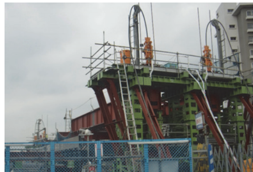
写真-5 ジャッキアップ設備
