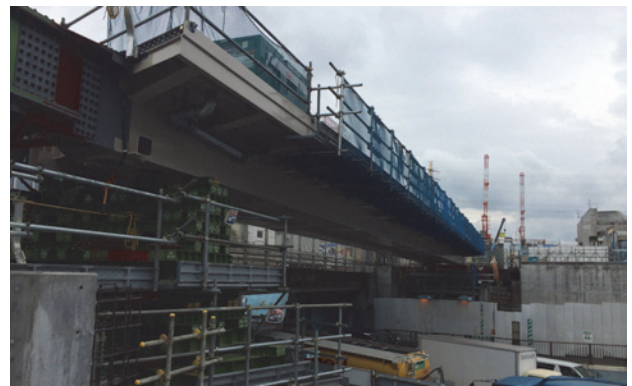
写真-8 送出しを終えた横断歩道橋
