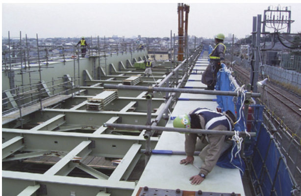
写真-1 環七工事桁組立て状況
