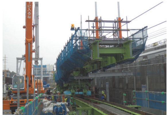
写真-3 吊上げ台車
