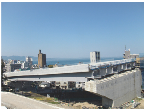
写真-9 上部工架設完了
