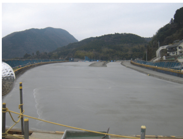
写真-8 床版コンクリート打設完了
