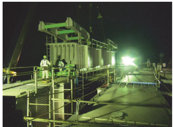
写真一6 落とし込み架設状況
