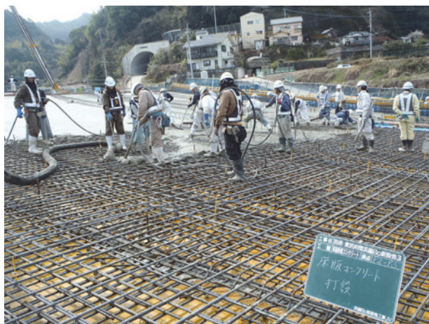
写真-7 床版コンクリート打設状況
