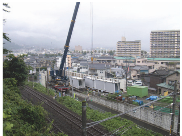
写真一4 桁地組立状況
