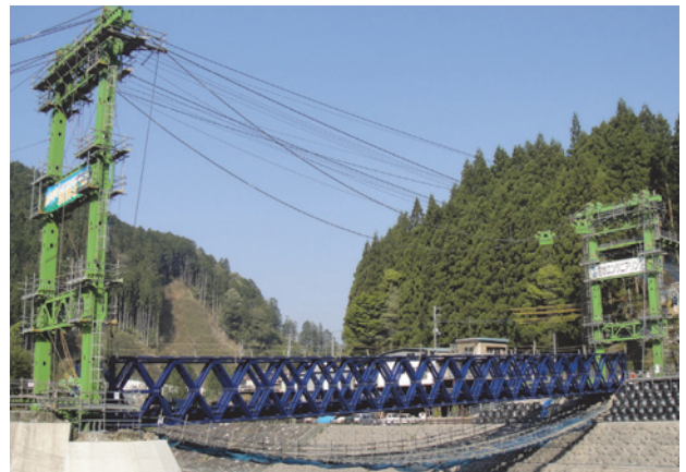
写真-11 架設完了
