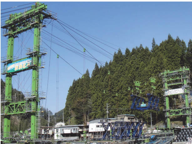
写真-9 桁架設状況
