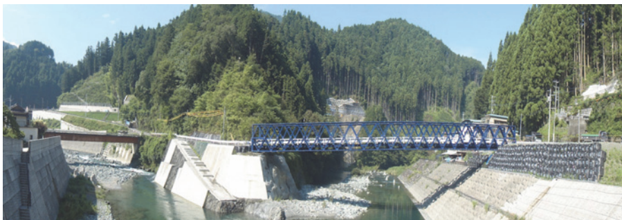
写真—1 仮橋 完成全景
