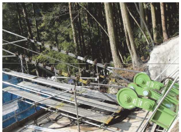
写真-3 A1鉄塔設備（下部）
