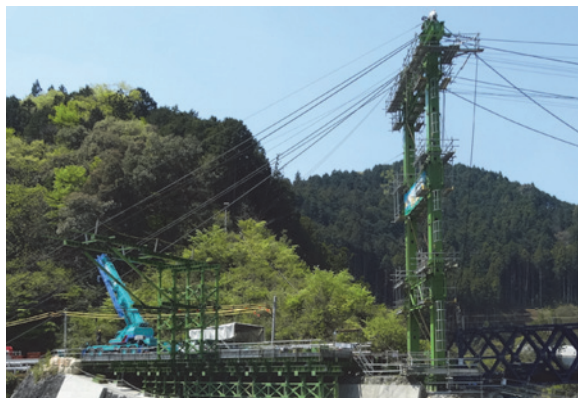
写真-6 A2鉄塔防護工
