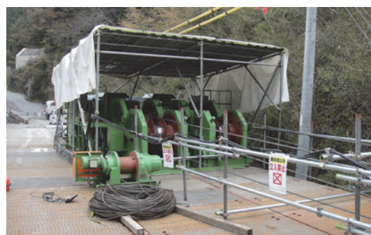
写真-8 ウィンチ設置状況
