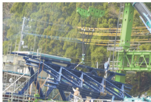
写真-7 桁建て起こし状況
