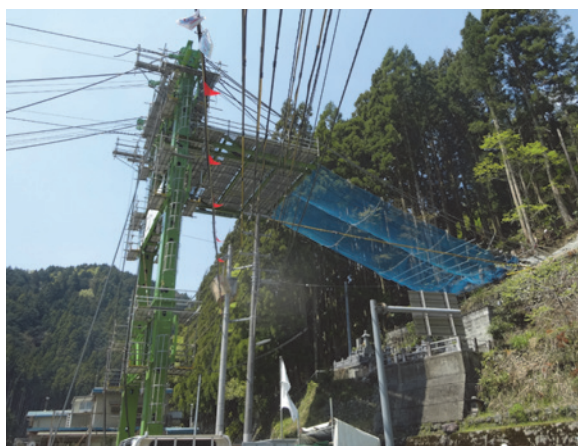
写真-5 A1鉄塔防護工
