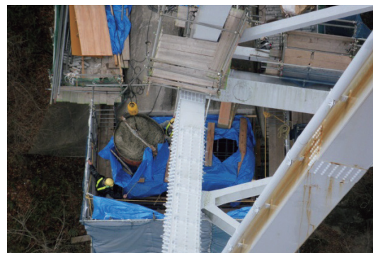
写真-9 クレーンによるバケット打設状況
