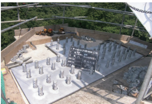
写真-7 一体型ベースプレート設置完了
