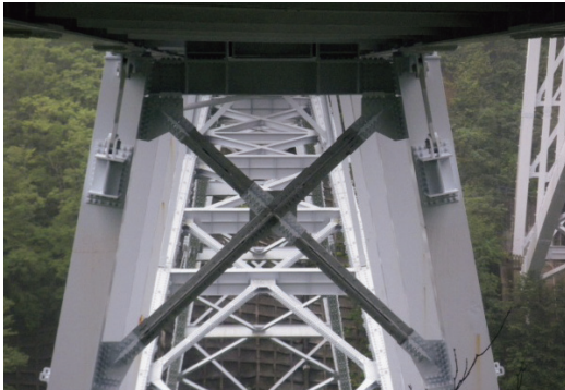
写真-5 座屈拘束装置施工完了
