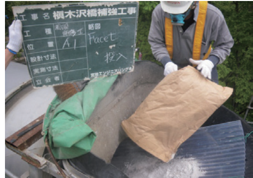
写真-12 Facet投入状況
