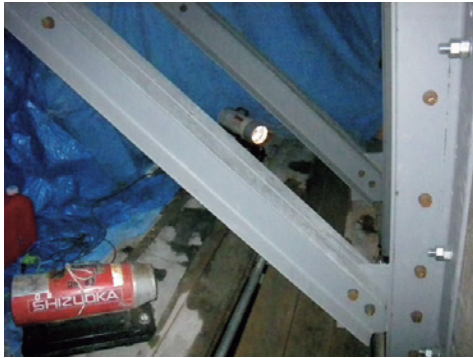
写真-10 ジェットヒーターによる寒中養生
