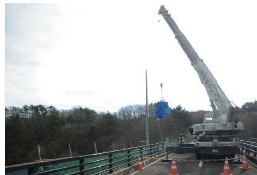
写真-8 クレーンによるバケット打設（橋面上）
