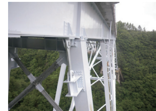
写真-14 上部施工完了
