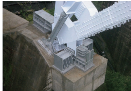
写真-13 基部施工完了
