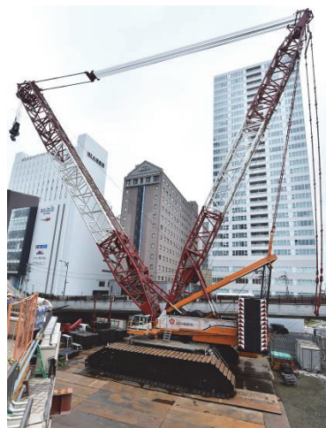
写真-3クレーン組立後全景
