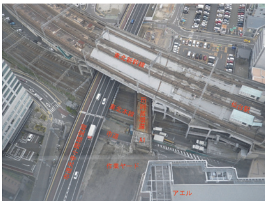
写真-2 ヤード周辺全景
