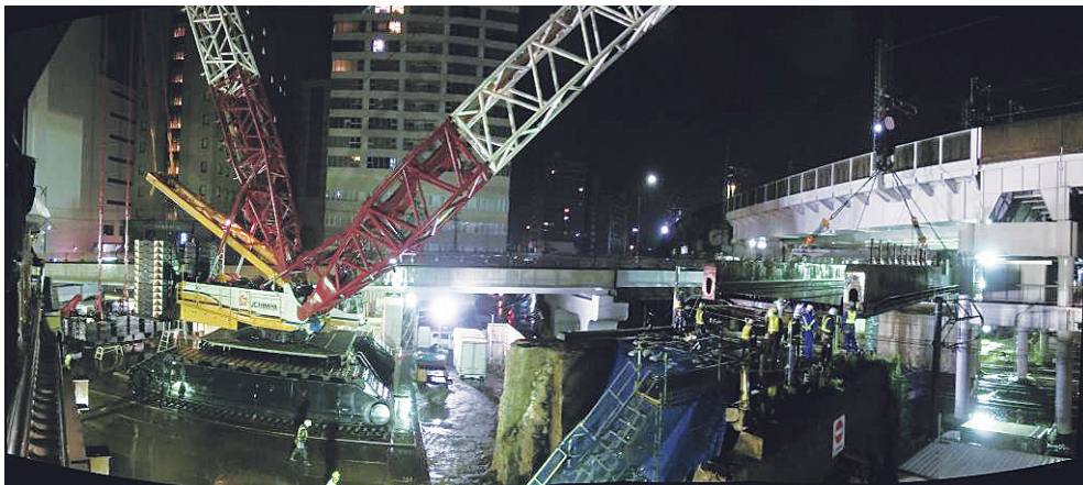
写真-4 桁地切り・巻き上げ
