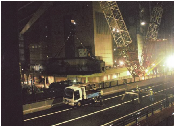
写真一七 市道上へ桁旋回
