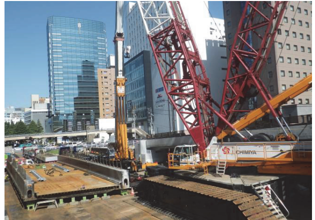
写真一九 撤去桁仮置き状況
