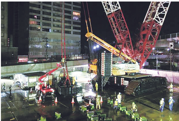
写真-5 SLカウンタウエイト切り離し
