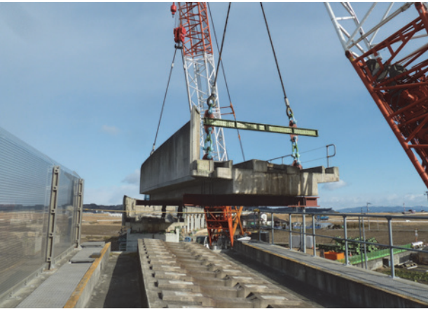
写真-8 Csdp-1撤去状況
