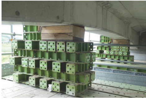
写真一 仮受け状況
