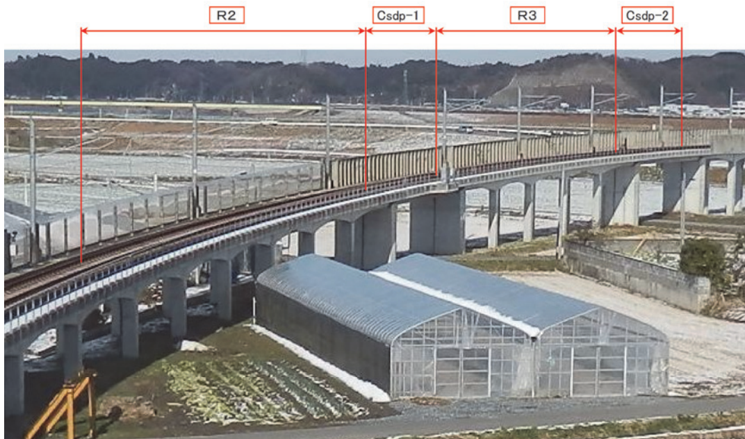
写真-16 施工前写真
