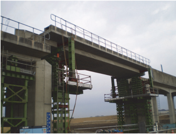
写真-15 Csdp-2ジャッキアップ完了
