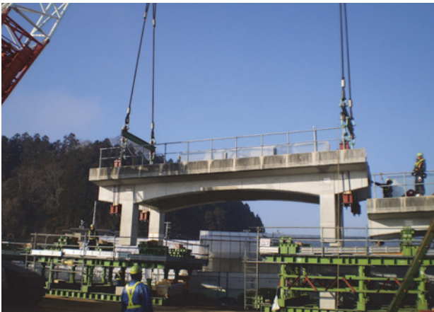
写真二 R2撤去状況
