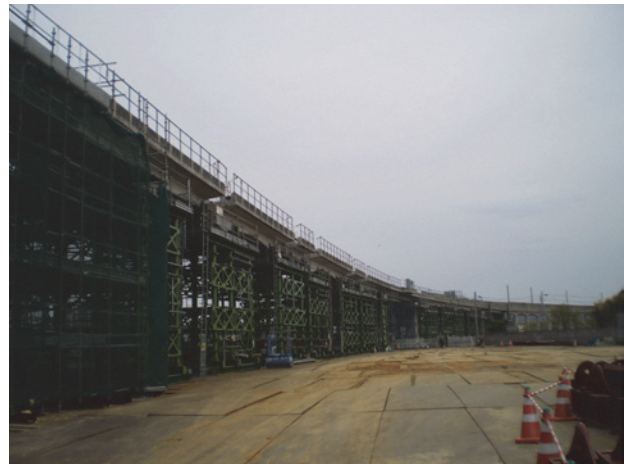
写真六 架設完了
