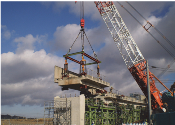
写真三 R3撤去状況
