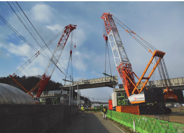
写真-9 Csdp-1撤去状況
