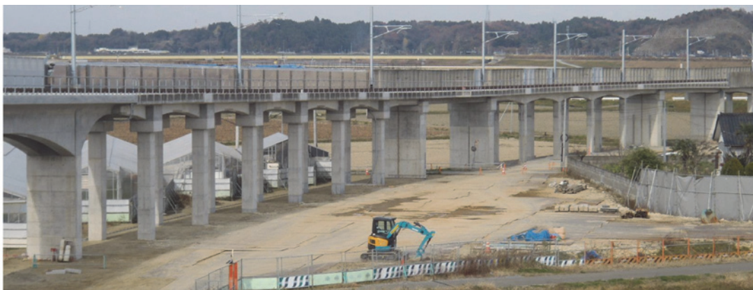
写真-17 施工完了写真
