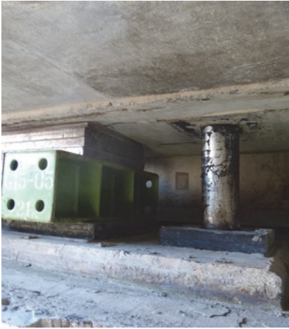
写真-7 Csdp-1鋼棒ストッパー
