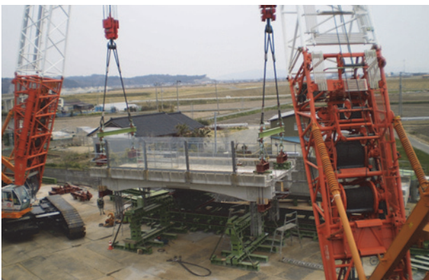
写真四 R2架設状況
