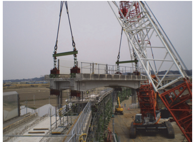
写真五 R2架設状況
