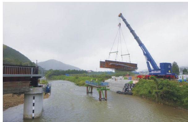
写真-3 河川内杭ベント設備
