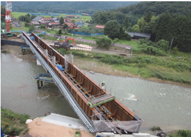
写真一4 桁架設完了
