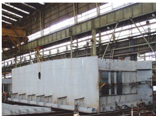
写真-1 箱桁の一体組立状況
