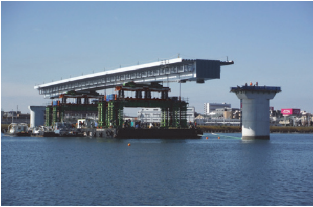
写真-14 桁吊り上げ完了
