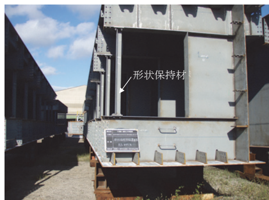
写真-2 形状保持材の設置状況
