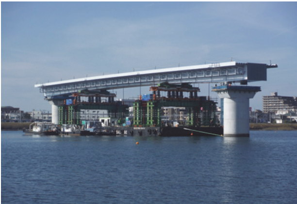
写真-15 台船シフト完了
