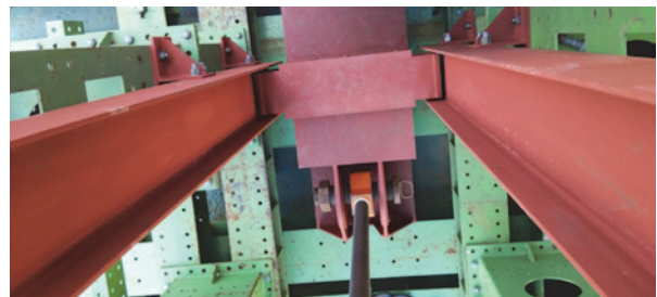
写真-13 ガイド設備
