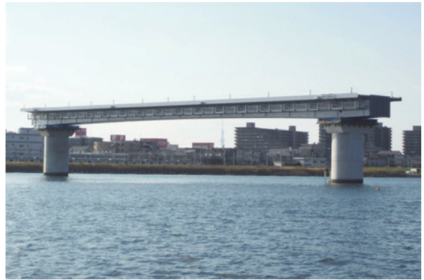
写真-16 桁据付け完了
