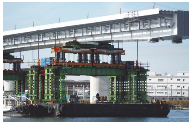
写真-12 桁扛上状況
