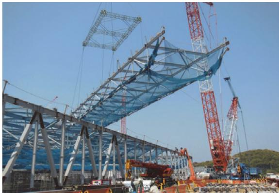
写真-13 小トラス箱組ブロックの建方
