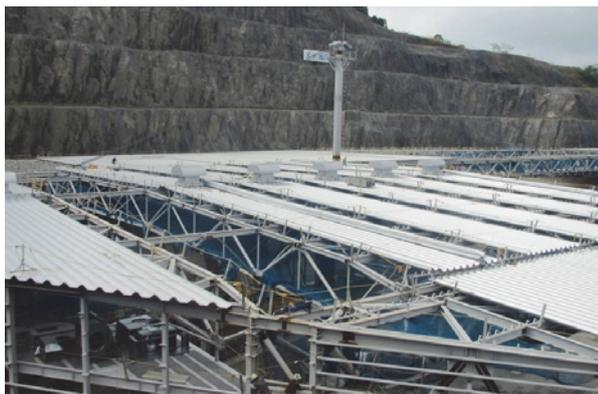
写真-19 1ブロックのスライド完了 (L=217m)
