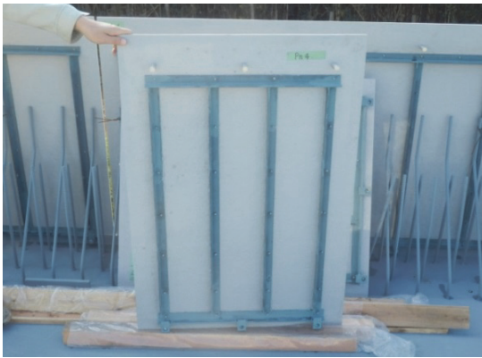
写真-1 FRP型枠内側
