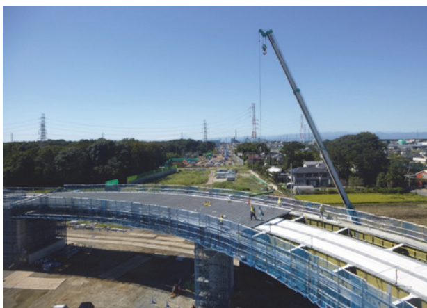
写真一九 FRP床版パネル設置
