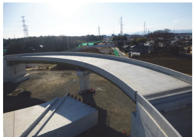
写真一〇 完成写真
