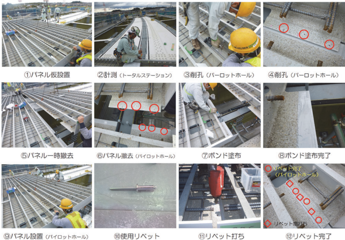
写真-4 FRP合成床版作業手順
