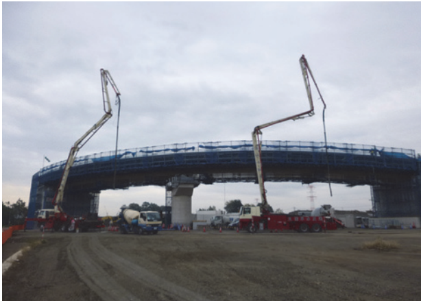
写真一七 床版コンクリート打設
