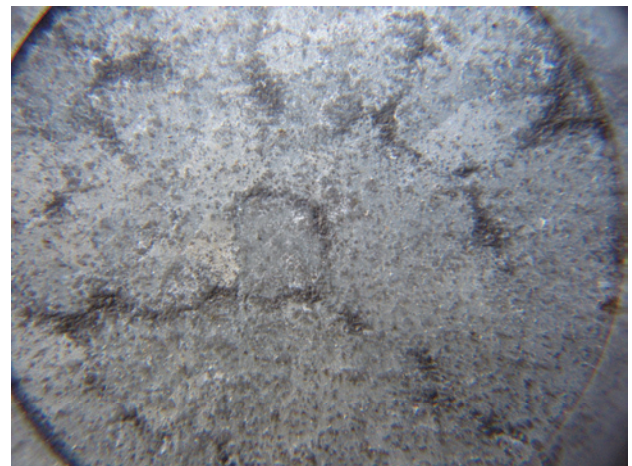
写真-6 熔融亜鉛めっき面の亀甲模様の拡大写真
