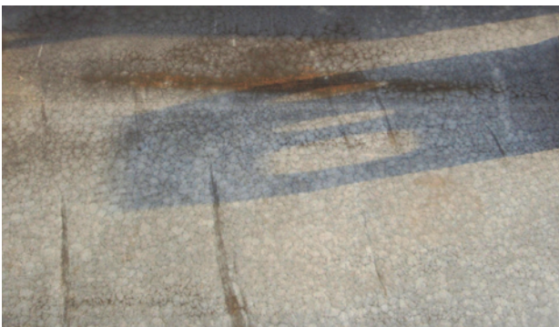
写真-3 熔融亜鉛めっき面の赤さび
