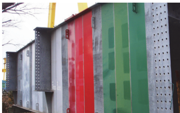
写真-1 実物大箱桁試験体の暴露状況
