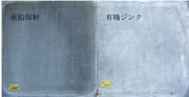
写真-2 補修面の外観
