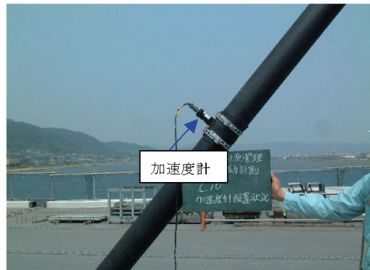
図-6 加速度計設置状況
