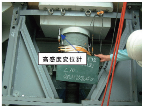
図-3 ケーブル定着部のジャッキ変位測定状況
