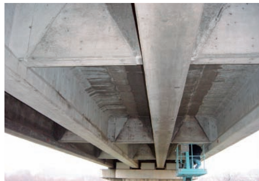
写真-3 S橋下面状況
