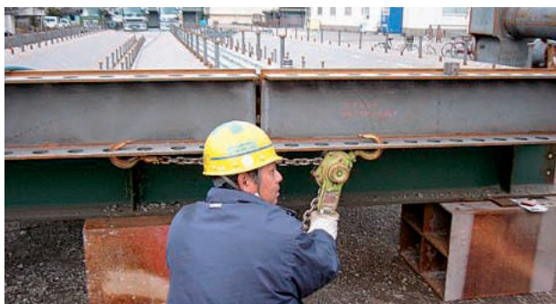
写真一 施工試験状況
