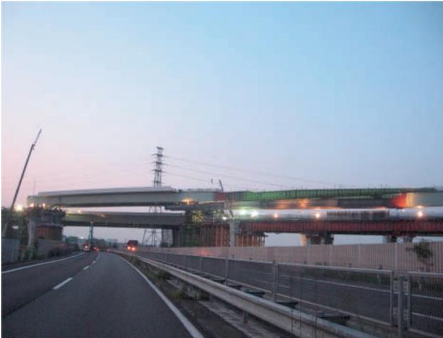
写真-6 送り出し後の本線桁（手前）とランプ桁（奥）
