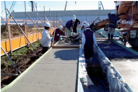
写真-3 縦桁制振コンクリート打設状況
