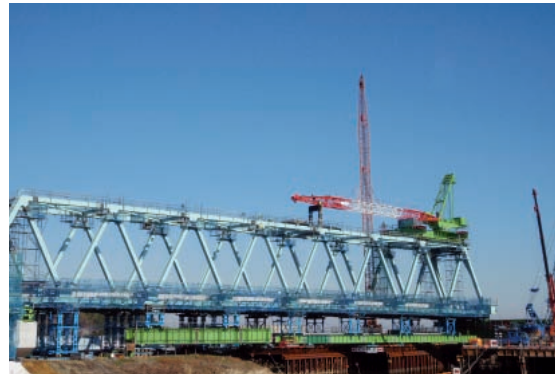
写真-1 P1-P2間 横取り前状況
