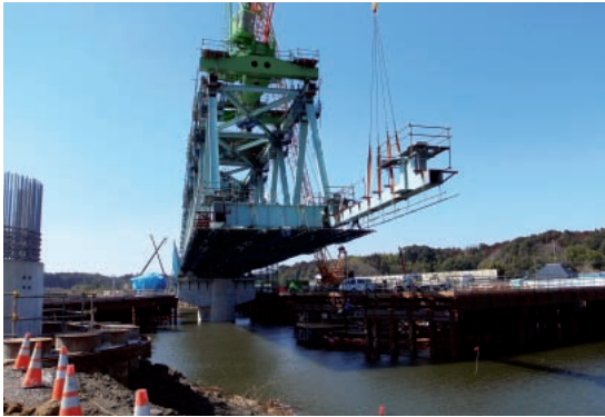
写真-2 張り出し架設状況
