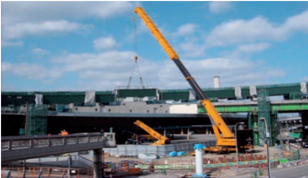
写真-10 BP9～10 橋脚間落とし込み架設
