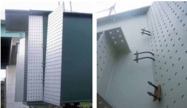
写真-8 添接板開閉治具
