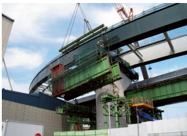
写真－14 大型ベントの解体
