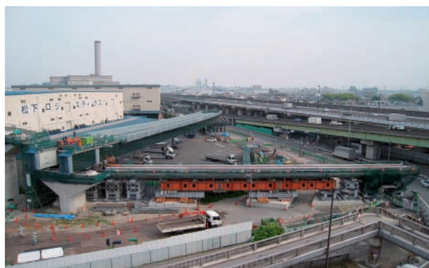
写真-2 回転横取り施工後
