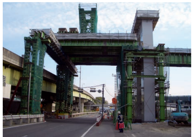
写真-12 BP10橋脚ベント
