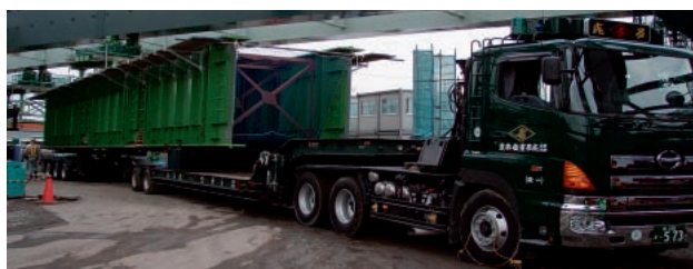
写真－13 ブロック化した部材の運搬
