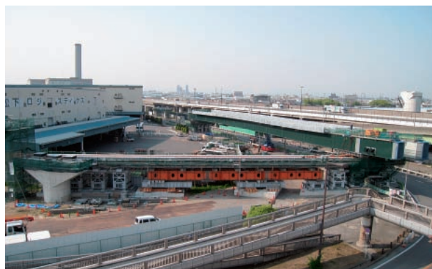
写真-1 回転横取り施工前
