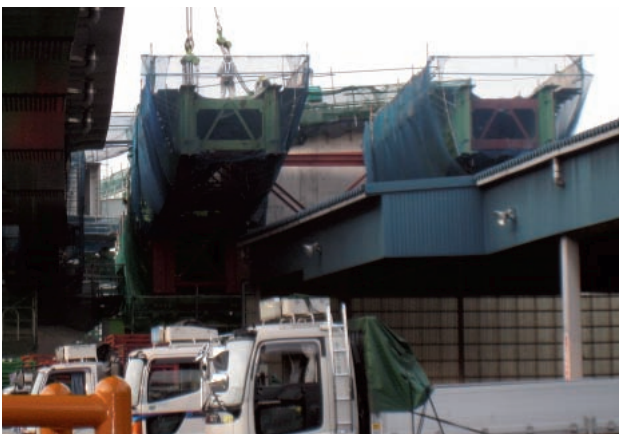
写真-11 BP9橋脚ベント
