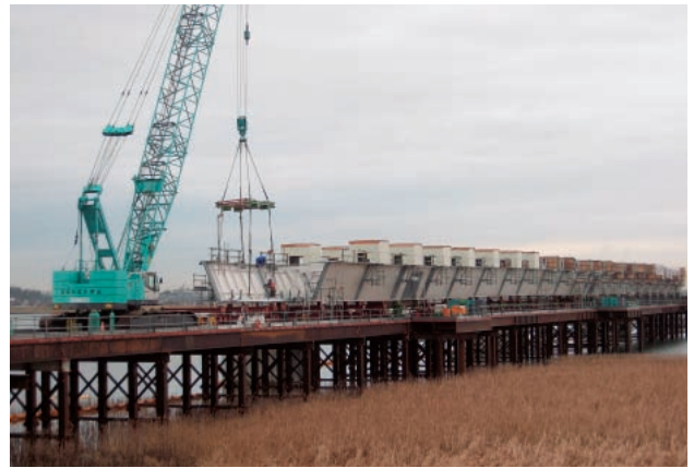
写真-5 栈橋上での地組立状況
