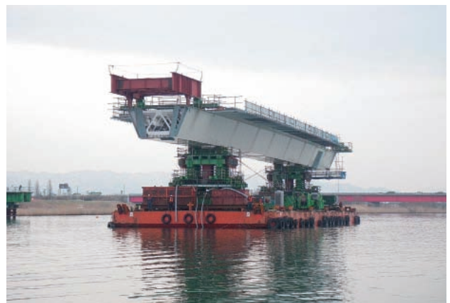
写真一七 台船離岸状況
