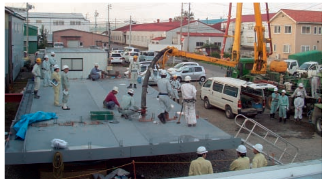
写真-1 コンクリート充填施工試験状況
