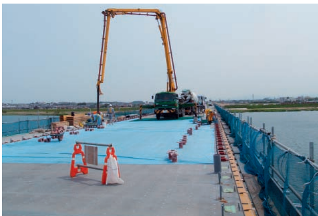
写真-2 コンクリート打設状況
