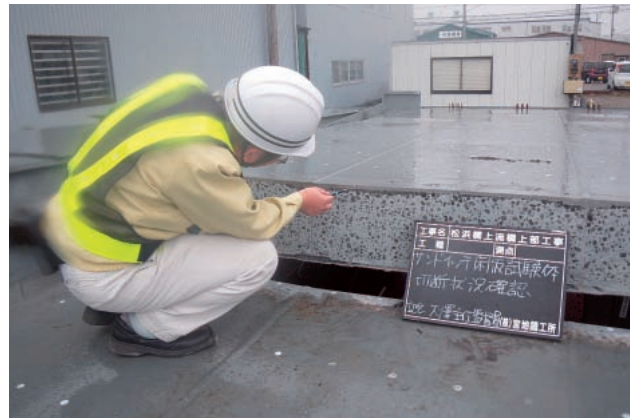
写真-3 供試体切断状況（充填状況破壊検査）
