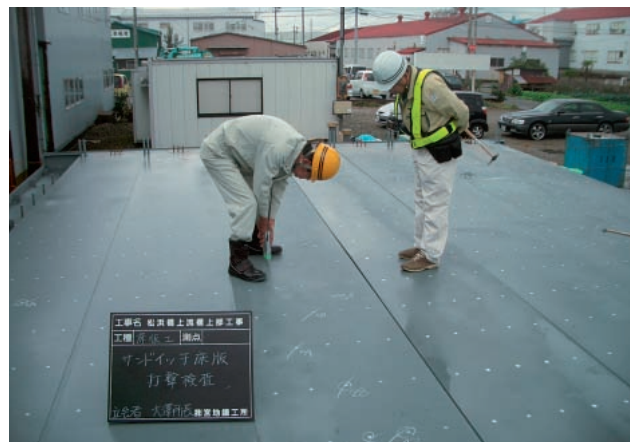
写真-4 非破壊検査（打音・シュミットハンマー試験）
