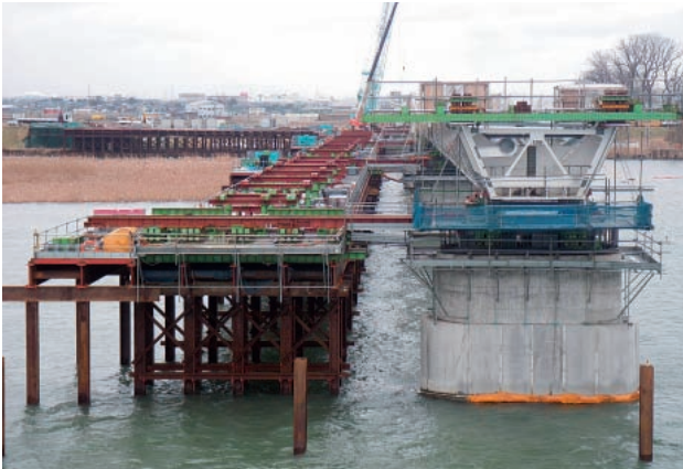
写真一六 横取架設完了
