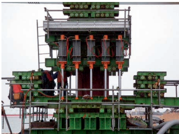
写真-8 降下システムの設置状況
