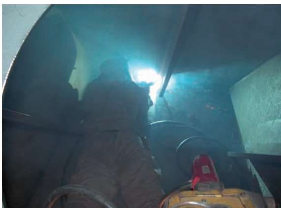
写真-3 トラス格点内の溶接状況
