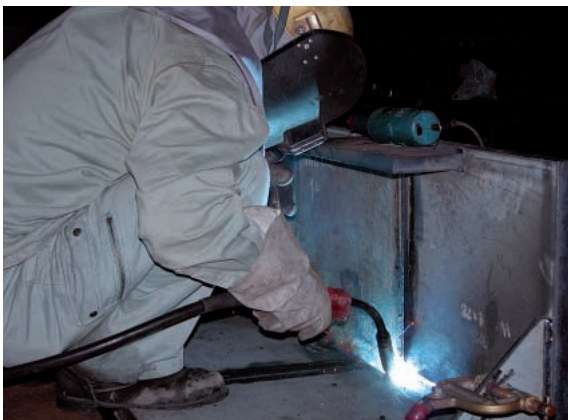
写真-6 小型試験の施工状況
