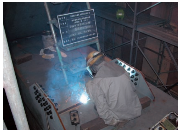
写真-7 Top PLの溶接状況
