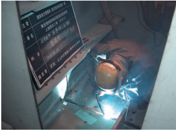
写真一8 Bott PLの溶接状況
