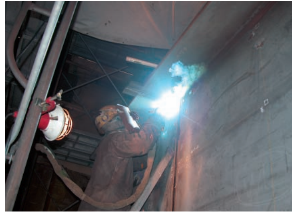
写真一10 交差部の溶接状況
