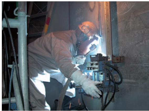
写真一9 Web PLの溶接状況
