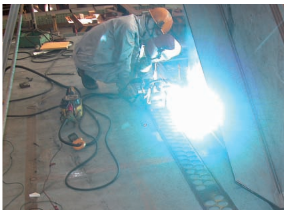
写真-4 かど継手溶接の施工状況
