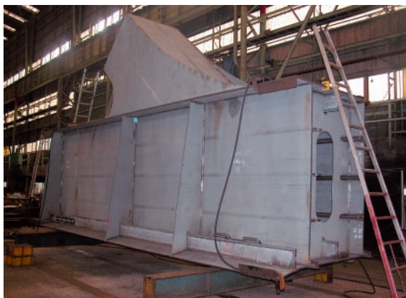
写真-2 実物大試験体の組立後
