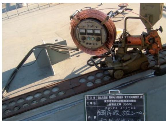
写真-7 ヤード溶接状況（鋼床版）
