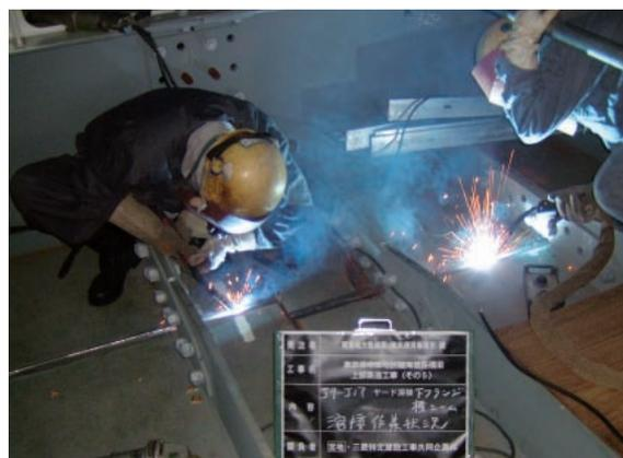
写真-8 ヤード溶接状況（主桁下フランジ）
