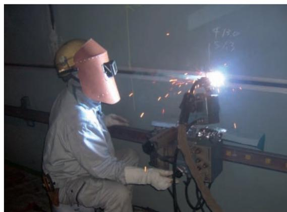
写真-10 ヤード溶接状況（剛結部柱）
