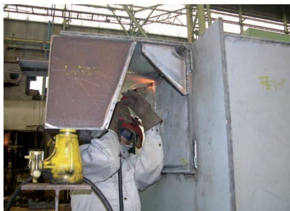
写真-1 鋼床版側ウェブ継手の溶接状況（立向き溶接）
