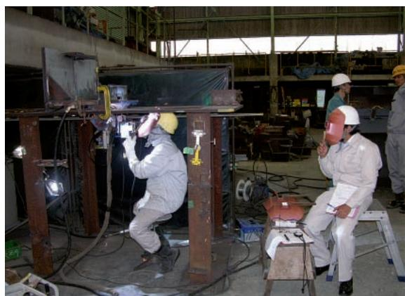
写真-2 板組み変化部の溶接状況（上向き溶接）
