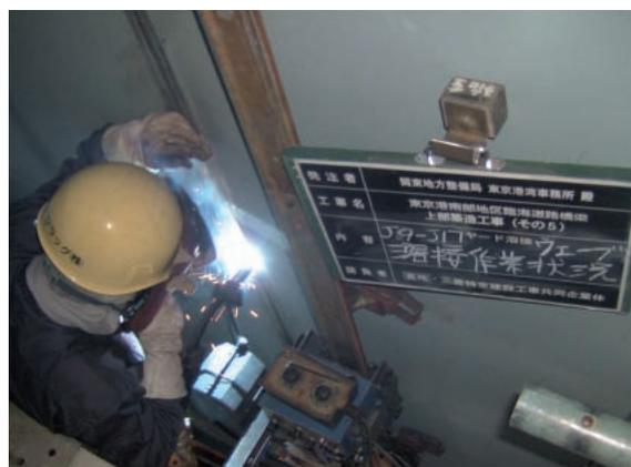
写真-9 ヤード溶接状況（主桁ウェブ）
